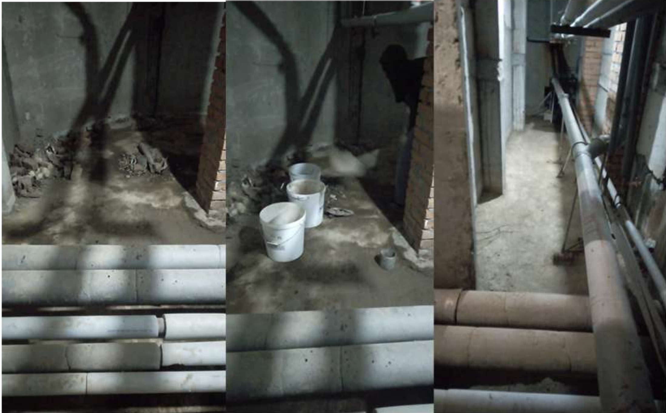
07-2022. Кутузовская 23. Уборка подвала.
