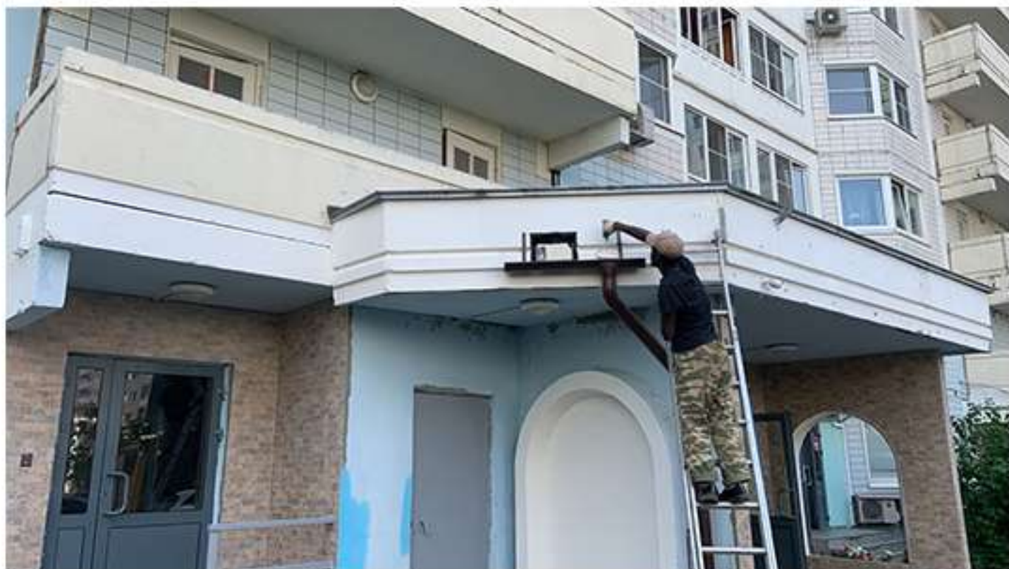
07-2022. Кутузовская 23. Ремонт входных групп.
