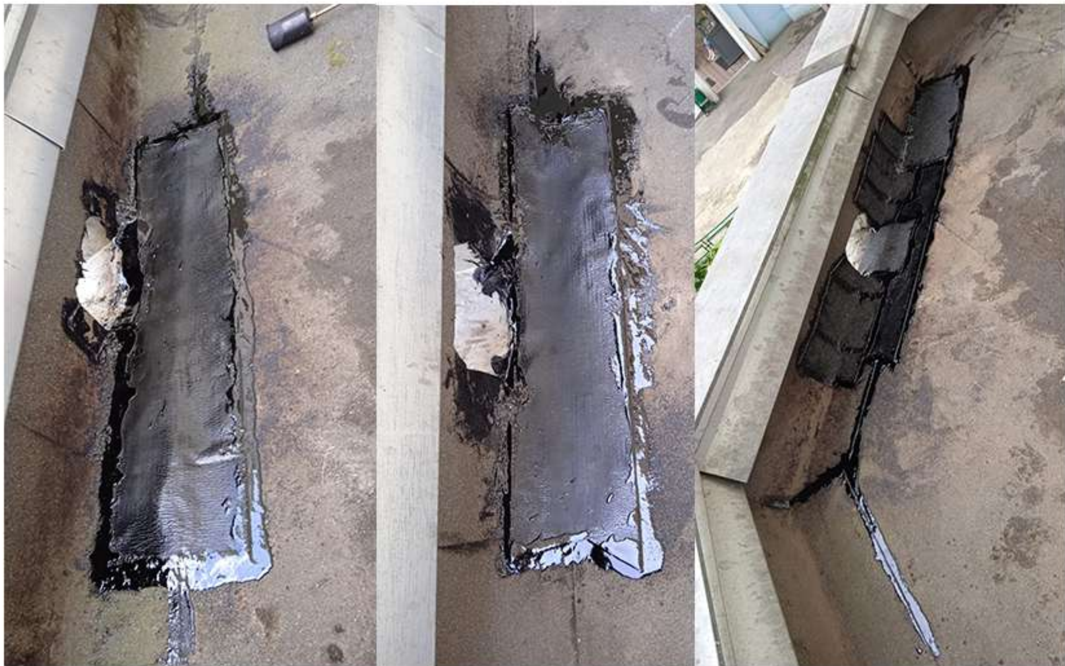
07-2022. Кутузовская 23. Ремонт козырьков.
