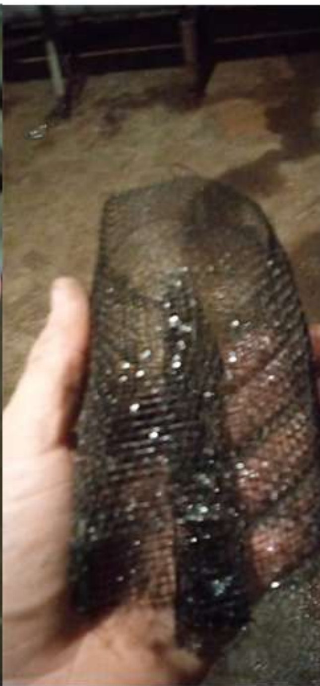
07-2022. Кутузовская 23. Промывка грязевиков.
