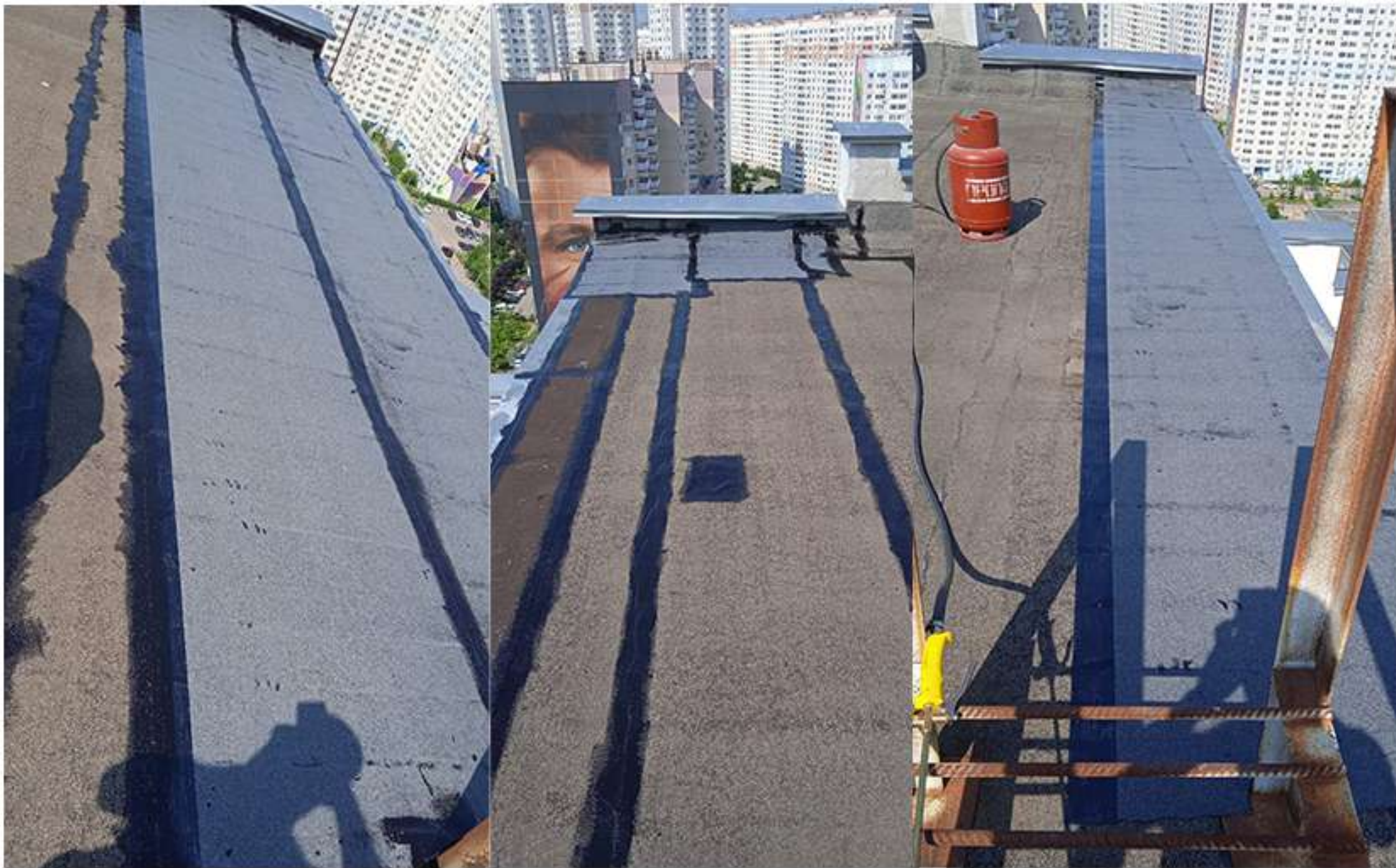
07-2022. Кутузовская 23 2й подъезд. Ремонт кровли.
