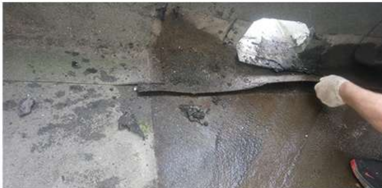
07-2022. Кутузовская 23. Ремонт козырьков.
