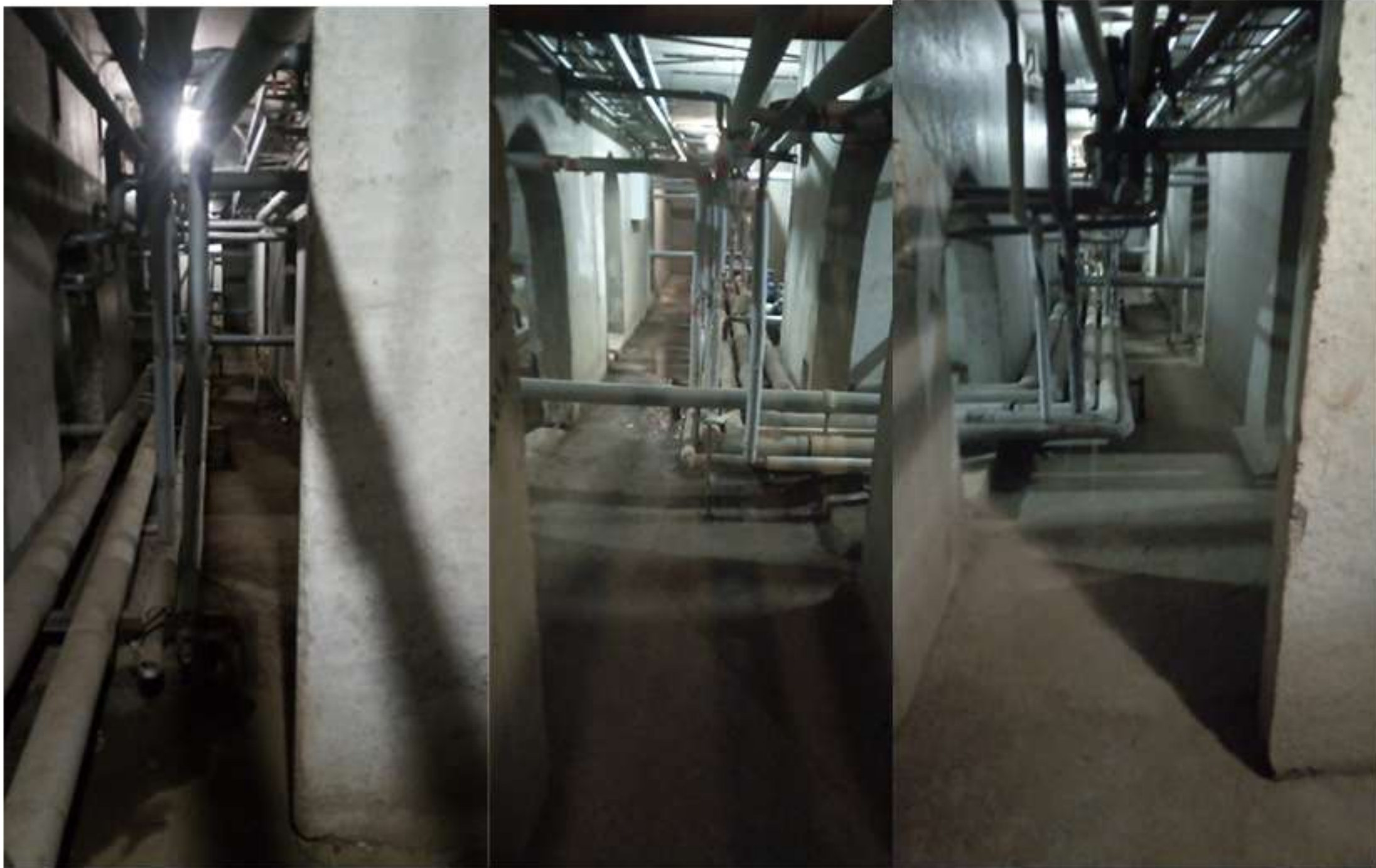
07-2022. КУтузовская 23. Обходы подвалов.
