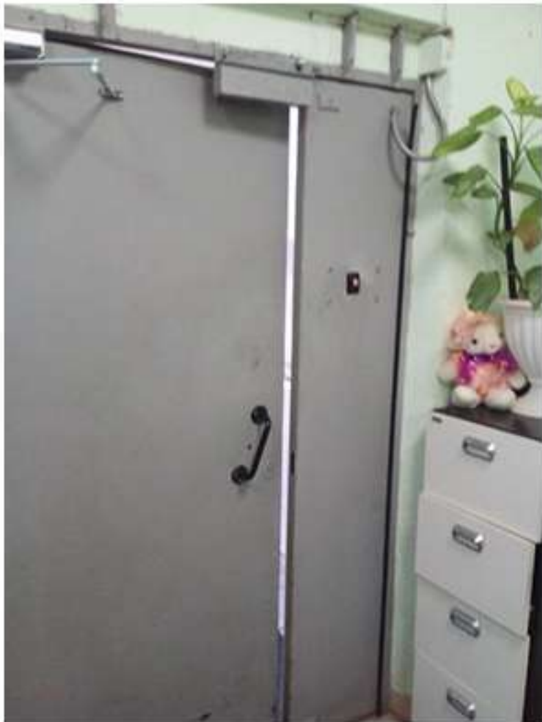
08-01 Кутузовская 23. Регулировка доводчика
