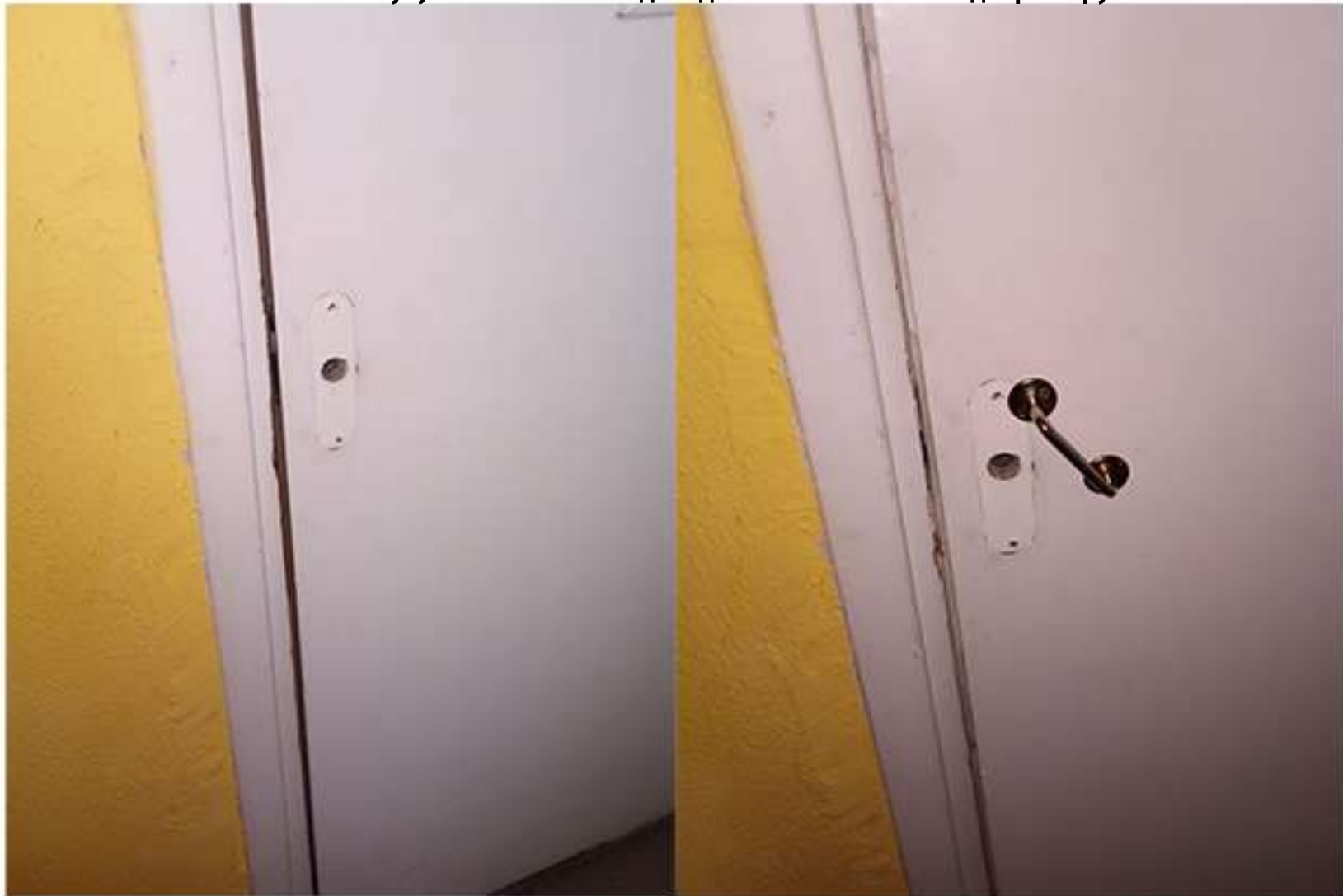
13-01 Кутузовская 23 6й подъезд 19й этаж. Установка дверной ручки
