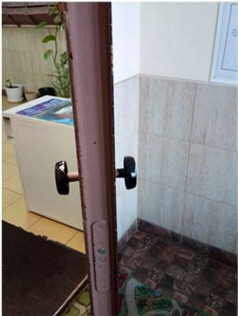
11-01 Кутузовская 23 2й подъезд Установка ручек.
