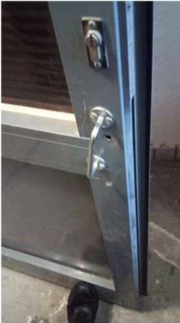
07-01 Кутузовская 23. 1й подъезд. Установка ручек на пожарных выходах.
