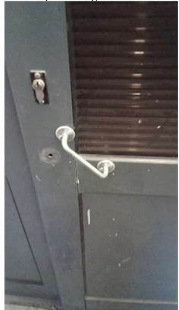
07-01 Кутузовская 23. 1й подъезд. Установка ручек на пожарных выходах.
