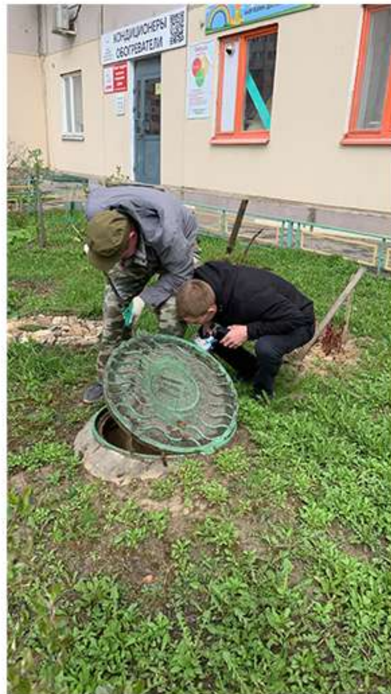
Проверка состояния ливневых колодцев.
