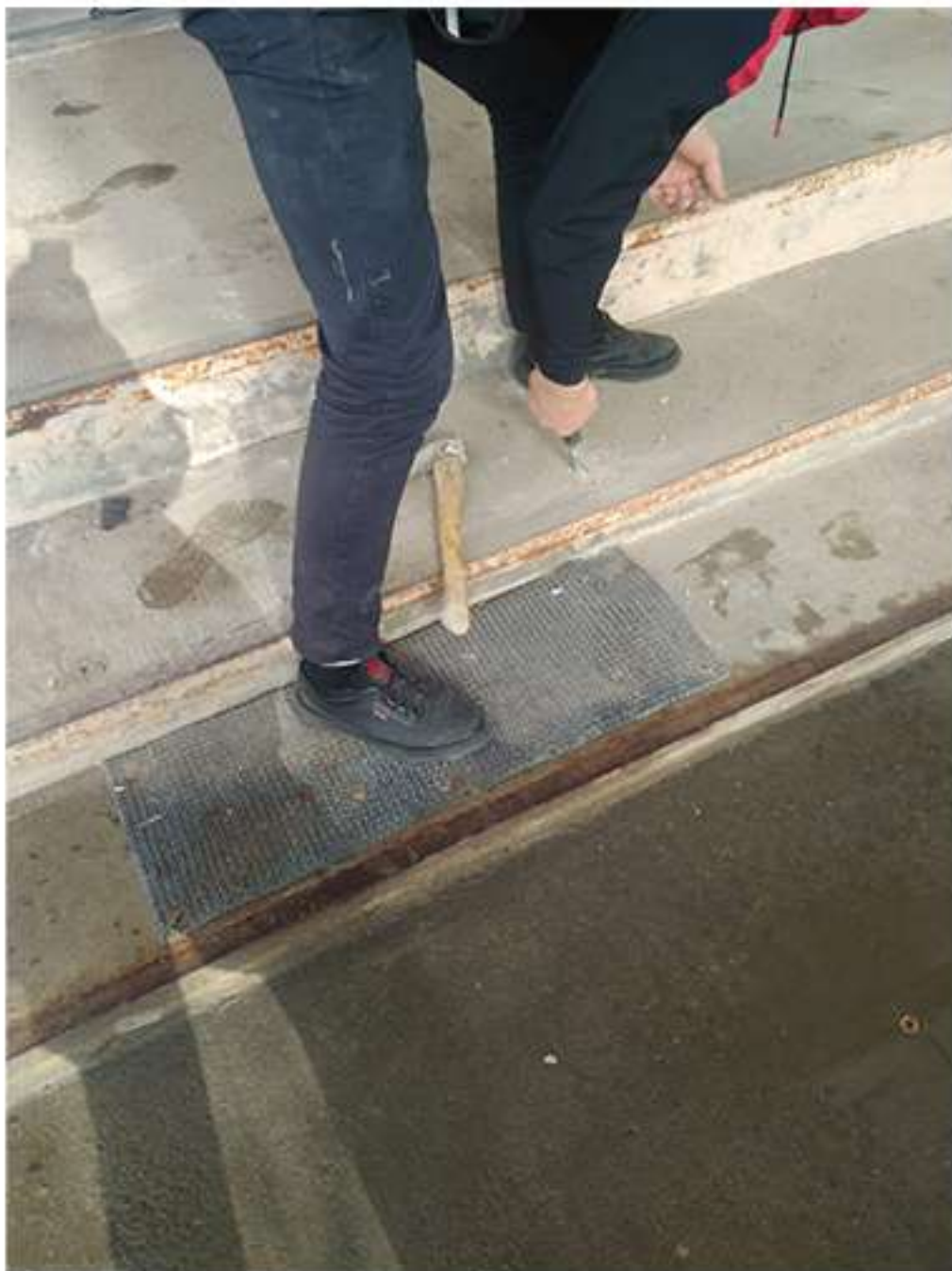
Демонтаж старых ковриков.
