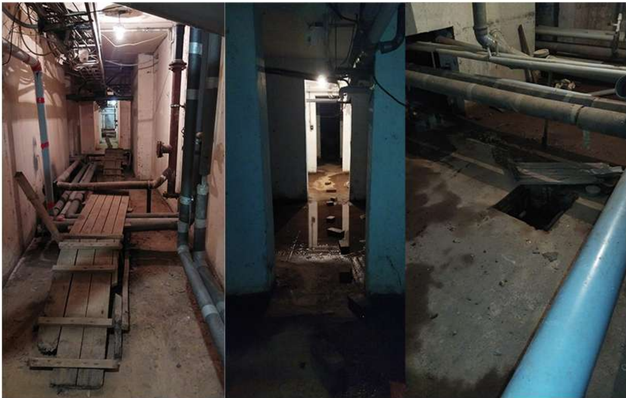
Чистяковой 42. Обход подвалов.
