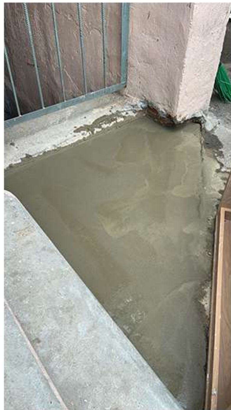
Чистяковой 42. 2й подъезд, вход в подвал. Устранение провала асфальтового покрытия.
