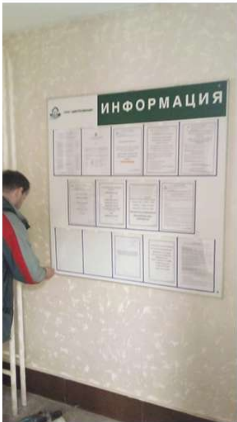
Установили информационные стенды после ремонта.
