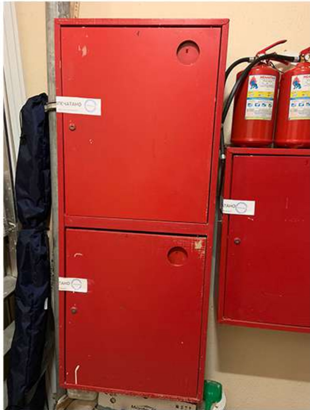
Кутузовская 33 (2й подъезд). Перекатали пожарные шланги. Опечатали шкафы.
