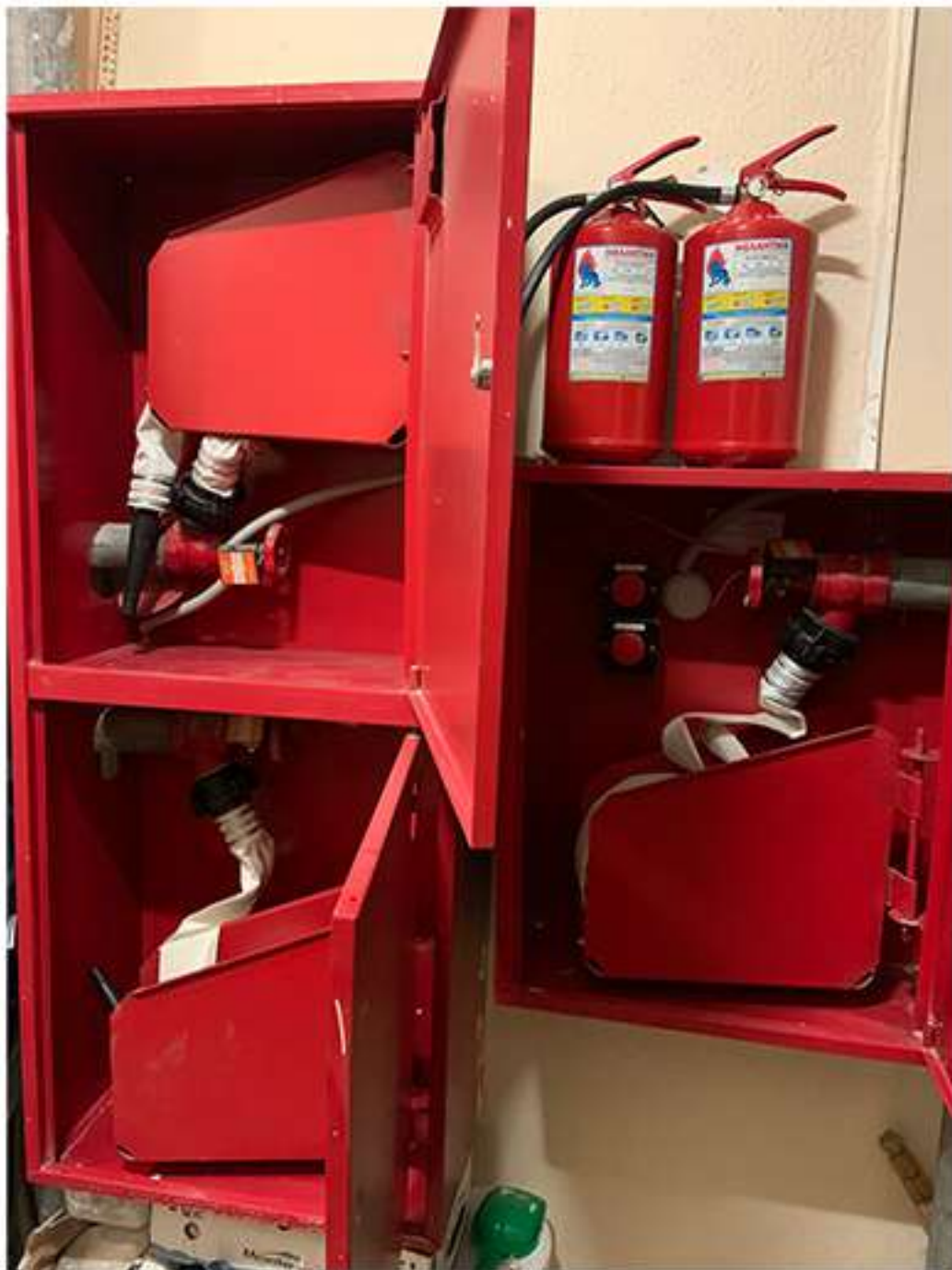
Кутузовская 33 (2й подъезд). Перекатали пожарные шланги. Опечатали шкафы.
