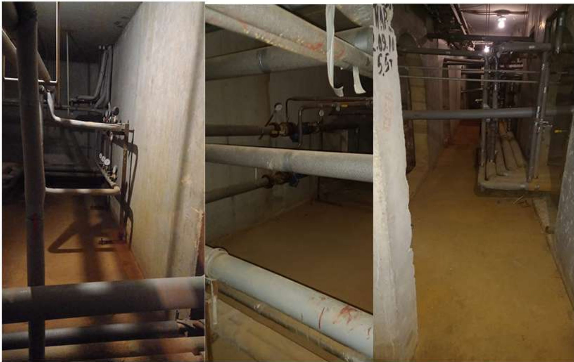
Кутузовская 33. Обход подвалов.
