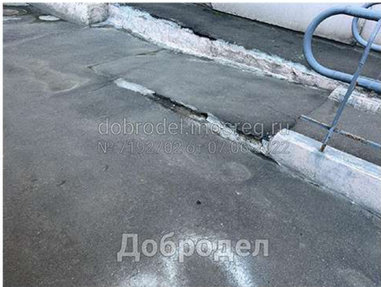
08-06. Чистяковой 42. Ремонт пандуса.
