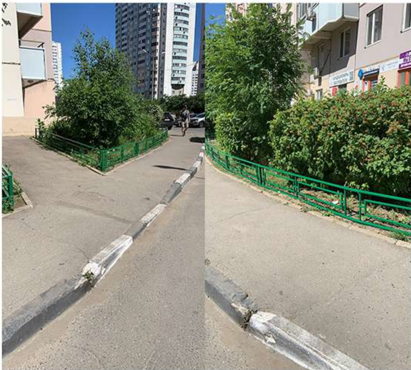
30-06. Чистяковой 42. Покраска ограждений.
