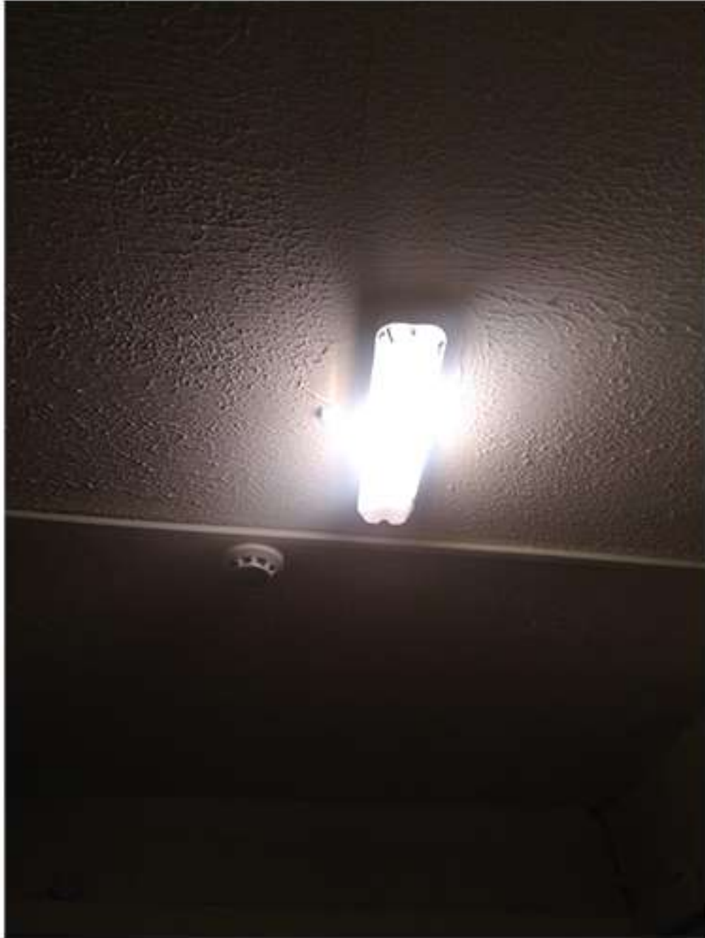
КУтузовская 33 (2й подъезд; 7й этаж). Замена ламп.
