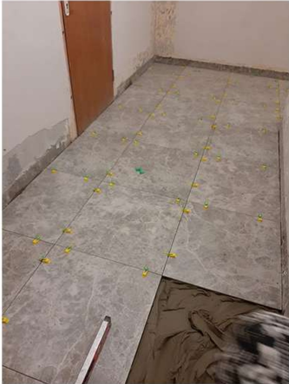
18-02. Чистяковой 42 (6й подъезд). Укладка плитки.
