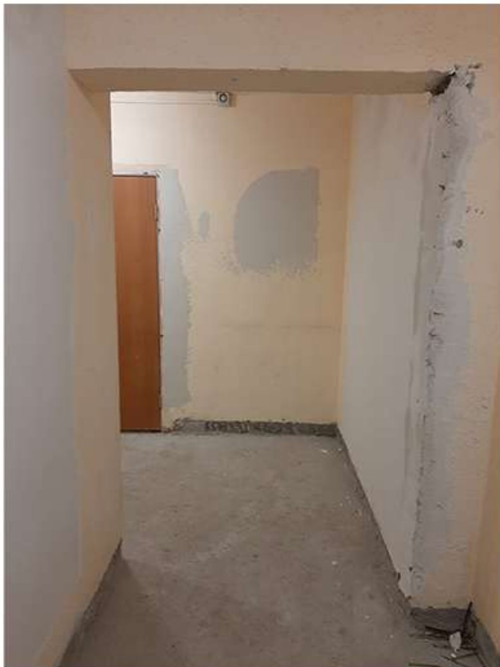
16-02. Чистяковой 42 (6й подъезд). Ремонт стен.
