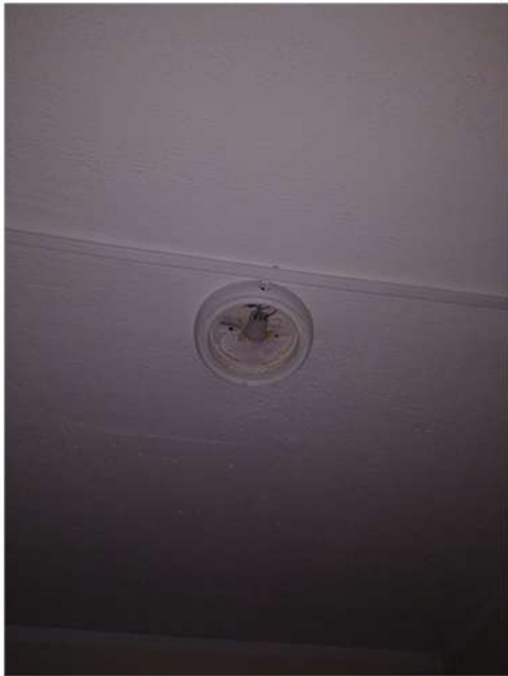
08-02. Чистяковой 42 (4й подъезд, 12й этаж). Замена ламп.
