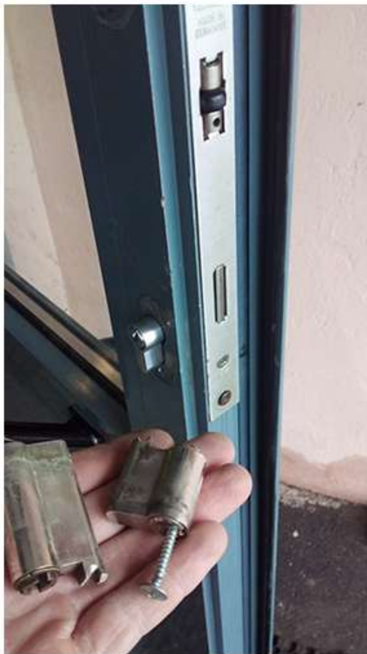
18-02. Чистяковой 42 (4й, 5й подъезды). Замена личинок в замках.
