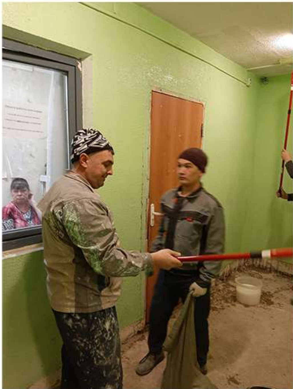
11-02. Чистяковой 42 (4й подъезд). Грунтовка стен и потолка.
