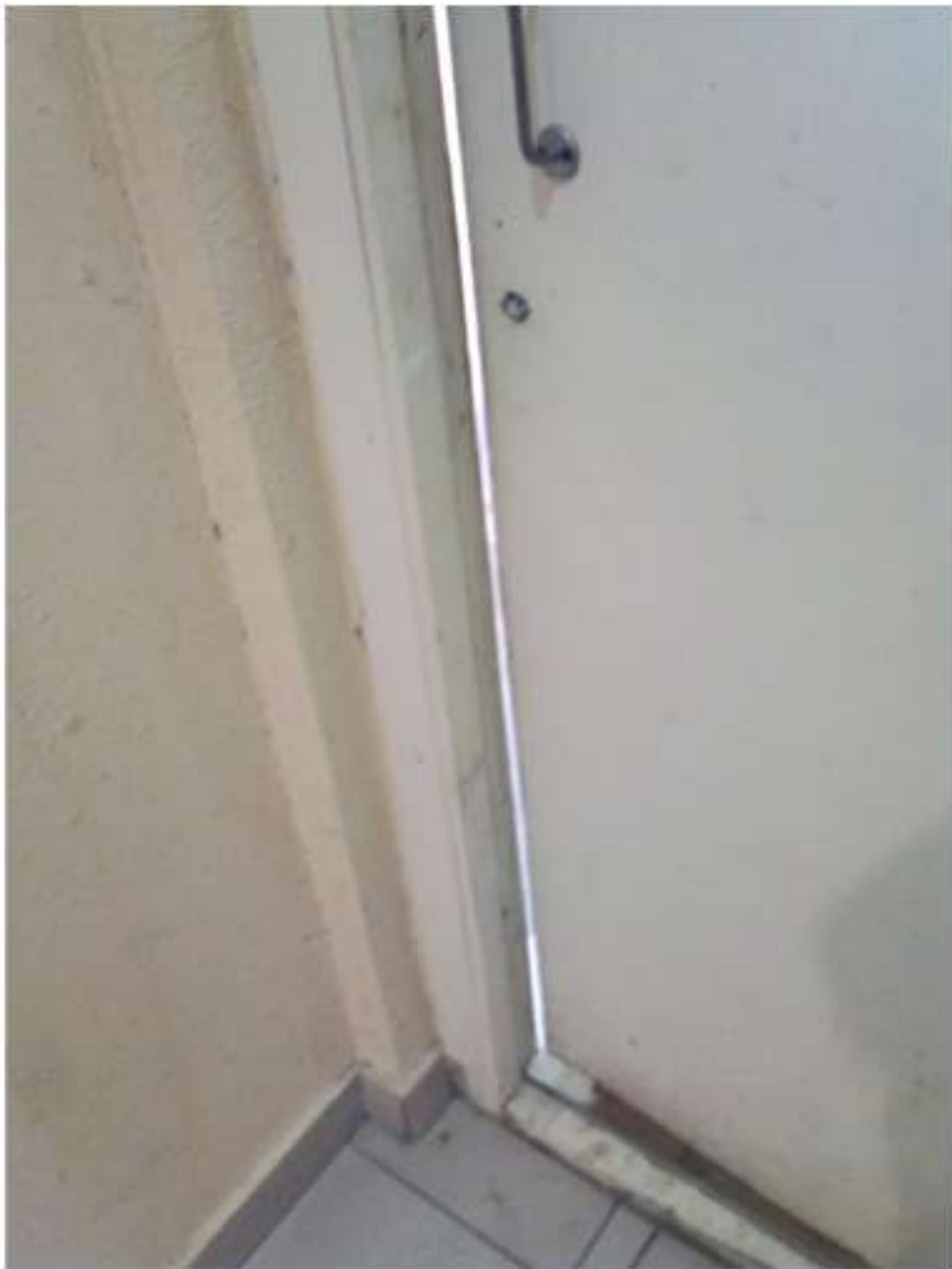
14-02. Чистяковой 42 (1й подъезд, 19й этаж). Ремонт примыкания дверей.
