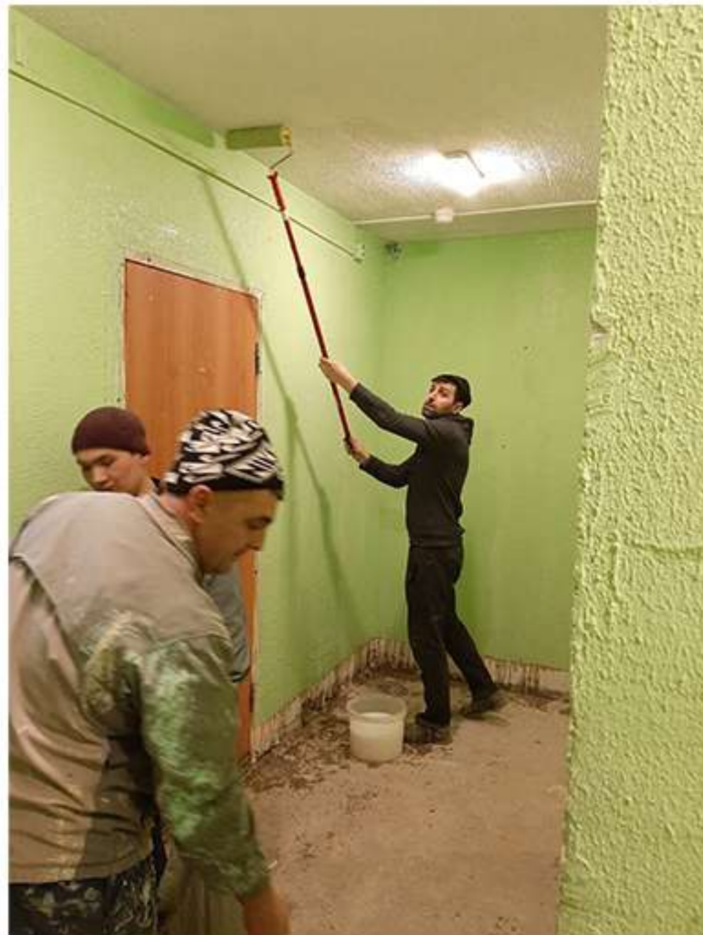
11-02. Чистяковой 42 (4й подъезд). Грунтовка стен и потолка.
