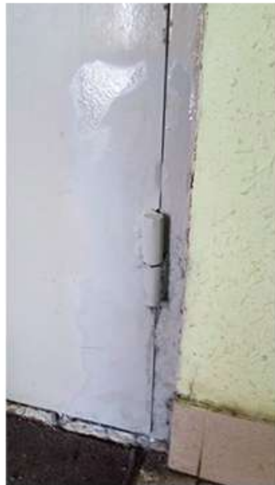
27-01 Чистяковой 42 4й подъезд. Ремонт, сварка петли на входной двери.
