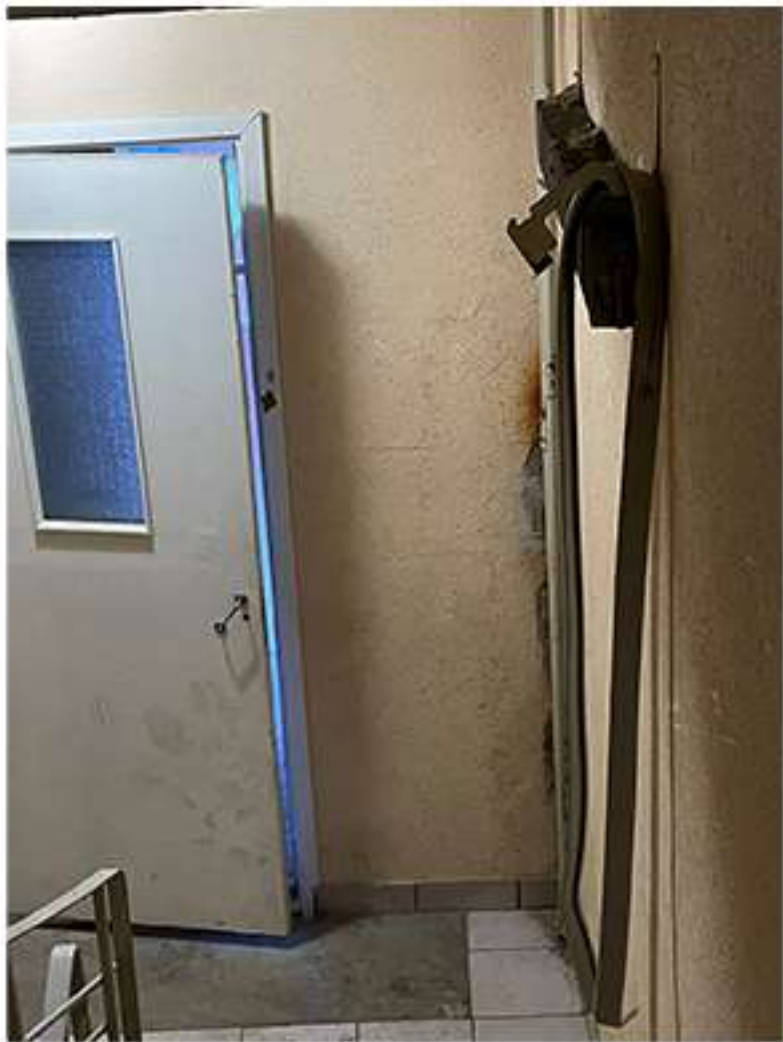
06-01 Чистяковой 42 5й подъезд 9й этаж. Ремонт перил.
