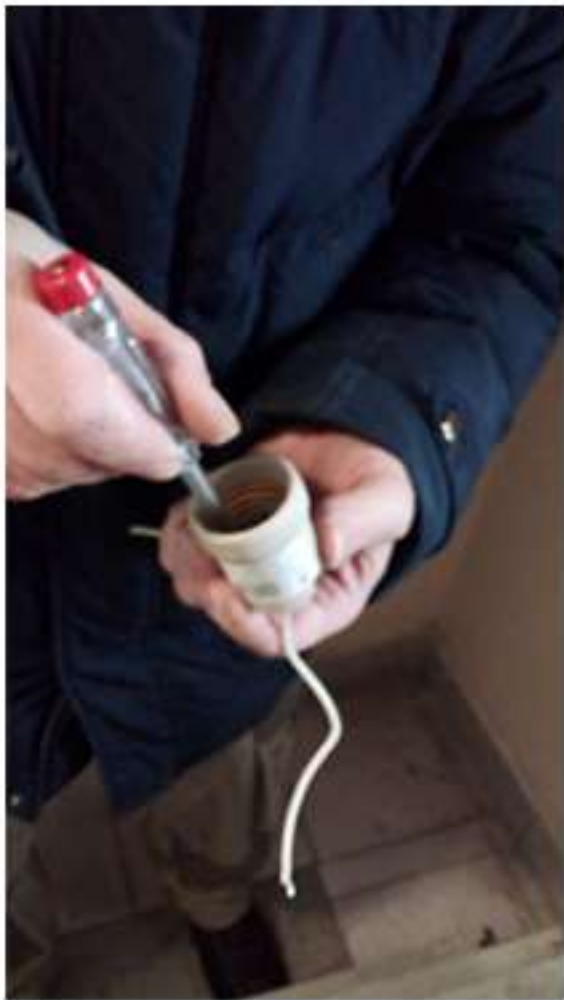
12-01 Чистяковой 42 3й подъезд 12й этаж. Ремонт патрона в светильнике.
