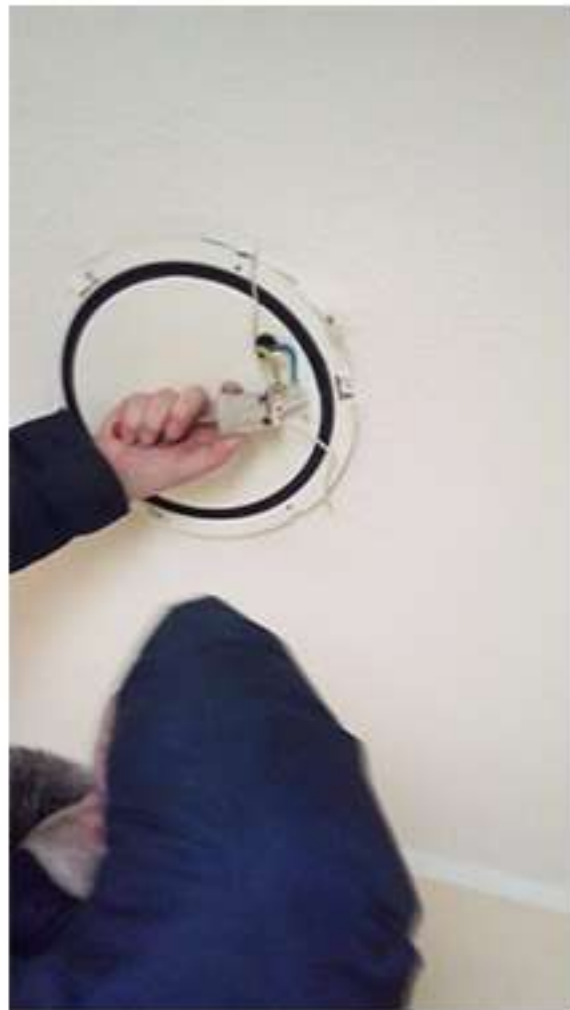
12-01 Чистяковой 42 3й подъезд 12й этаж. Ремонт патрона в светильнике.
