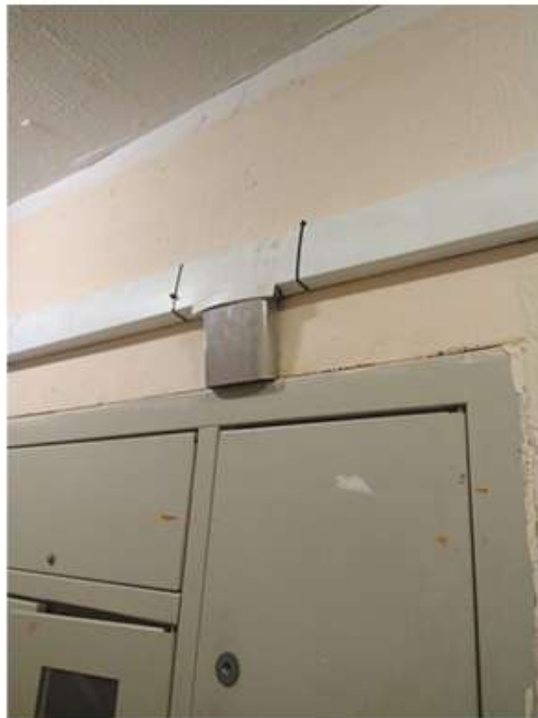
27-01 Кутузовская 33 2й подъезд 11й этаж. Установка кабель-канала.
