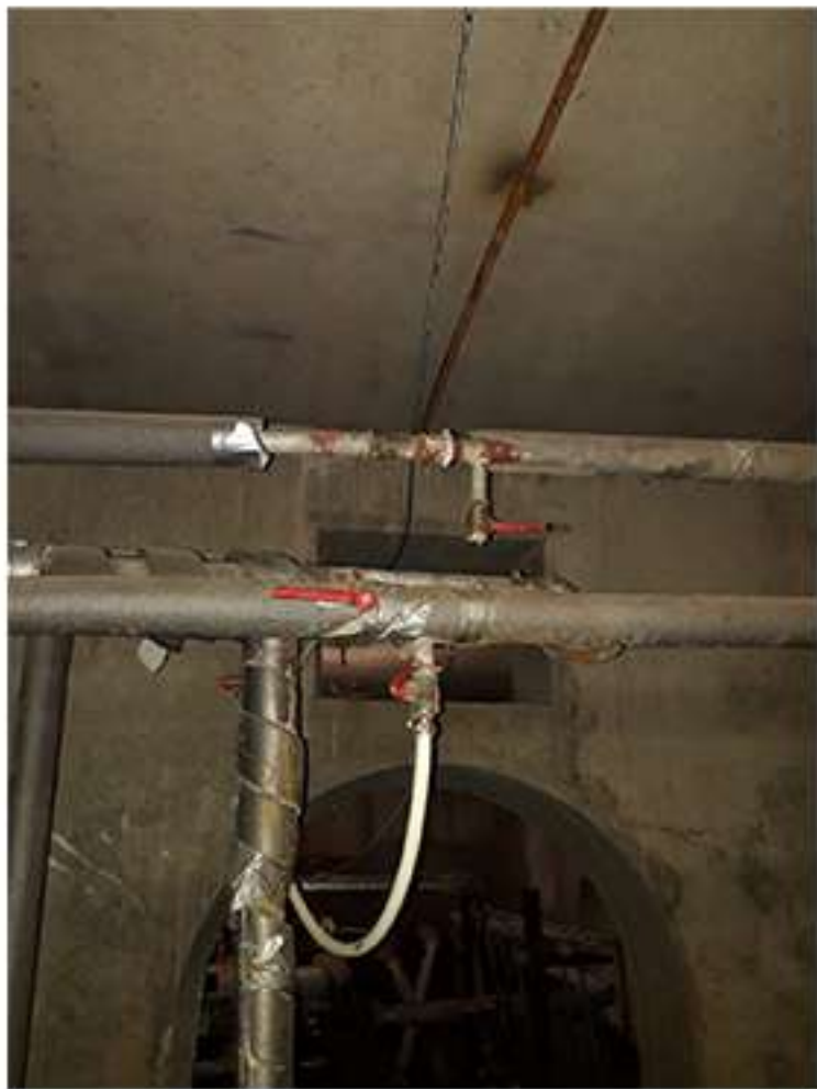
05-01 Кутузовская 33. Обход техэтажа.
