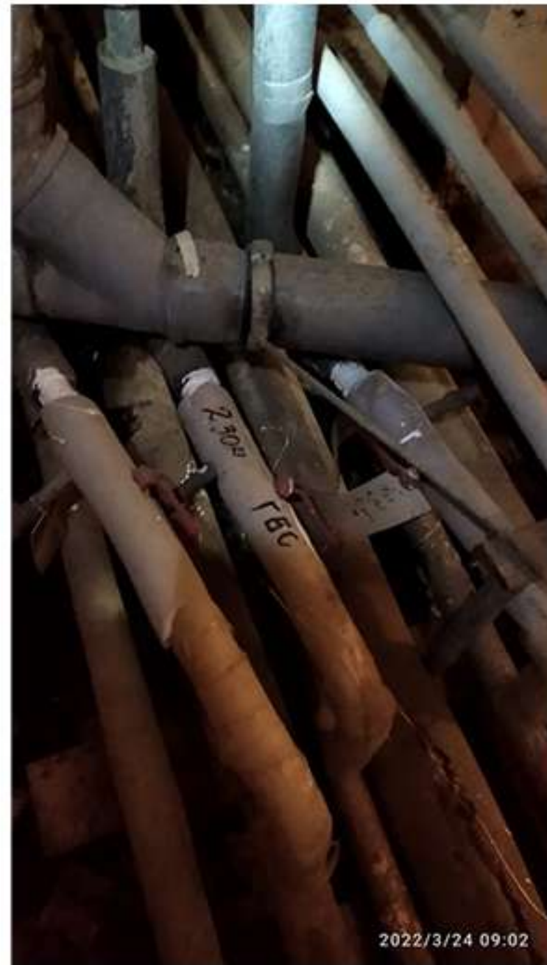
24-03. Чистяковой 42. Грунтовка резьбовых и сварных соединений.
