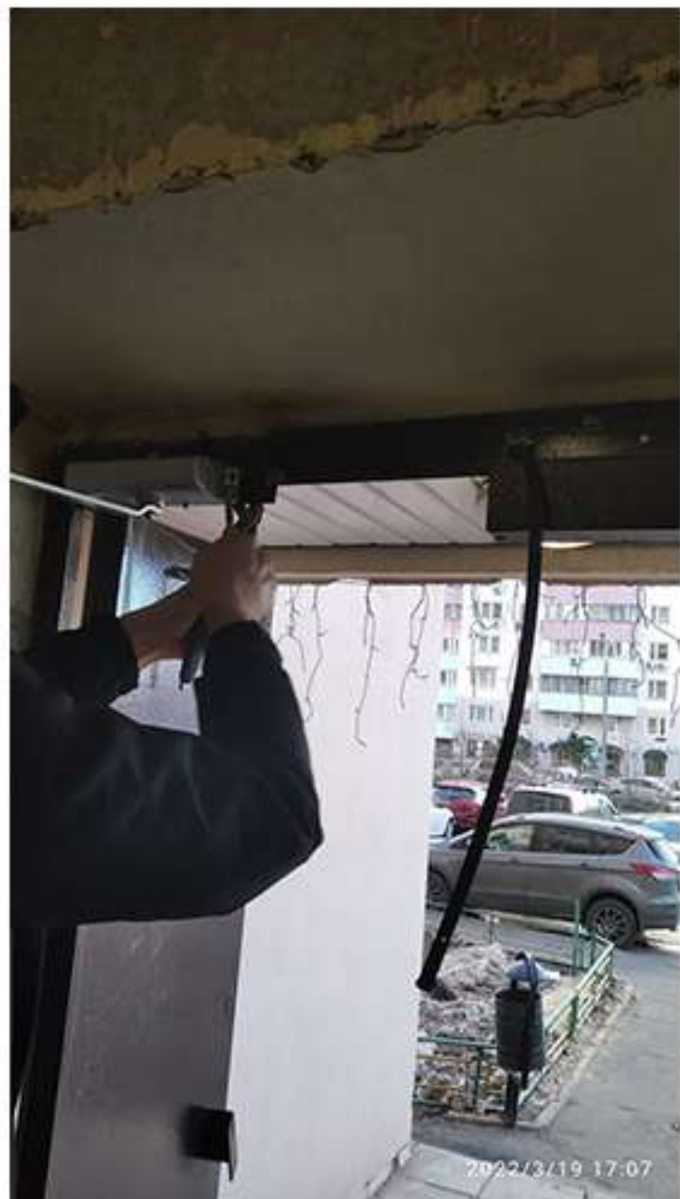
19-03. Чистяковой 42 (3й подъезд; пожарный выход). Ремонт доводчика.
