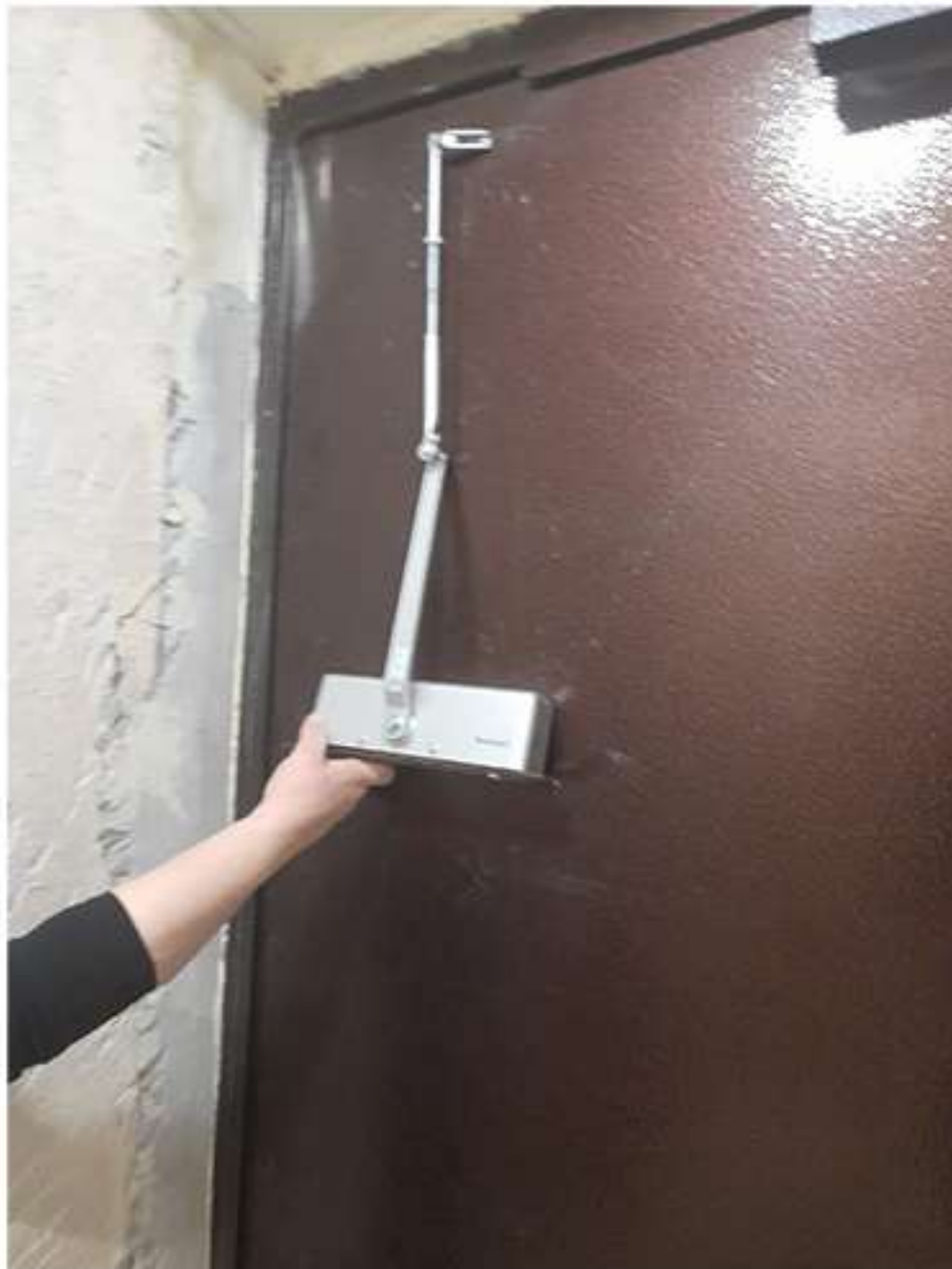
19-03. Чистяковой 42 (3й подъезд; пожарный выход). Ремонт доводчика.
