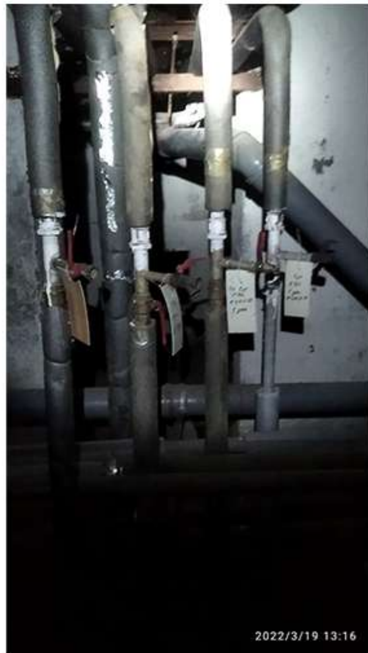
19-03. Чистяковой 42. Покраска сгонов и резьбовых соединений. Маркировка стояков.
