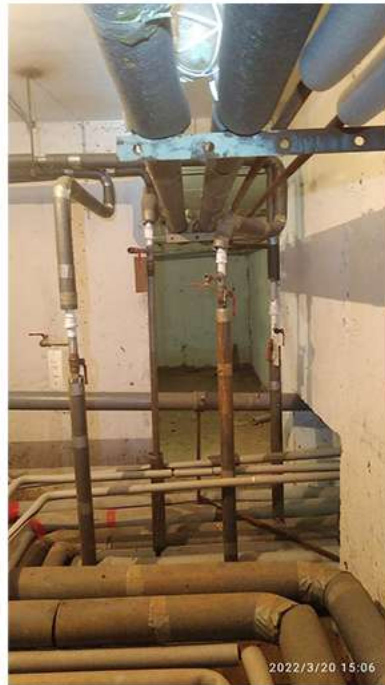
20-03. Чистяковой 42. Грунтовка резьбовых и сварных соединений. Маркировка стояков.
