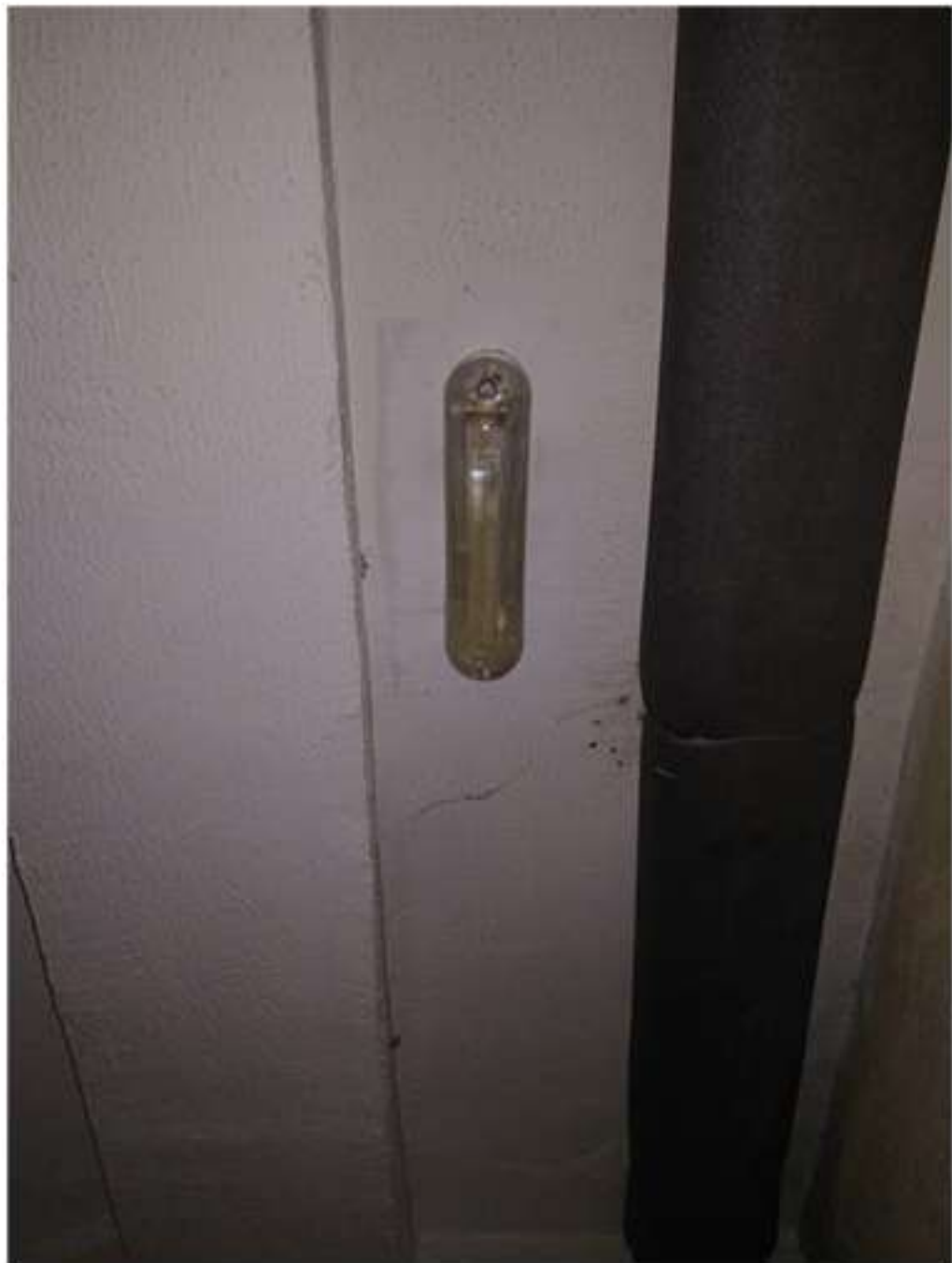
23-03. Чистяковой 42 (5й подъезд). Замена ламп.
