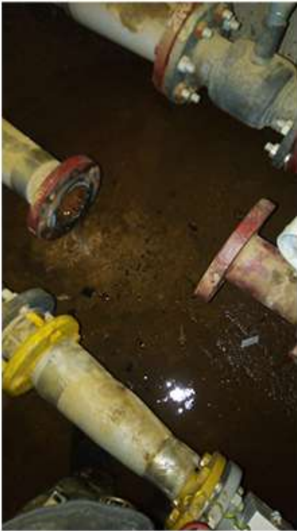
Кутузовская 33. Замена задвижки на вводе горячего водоснабжения.
