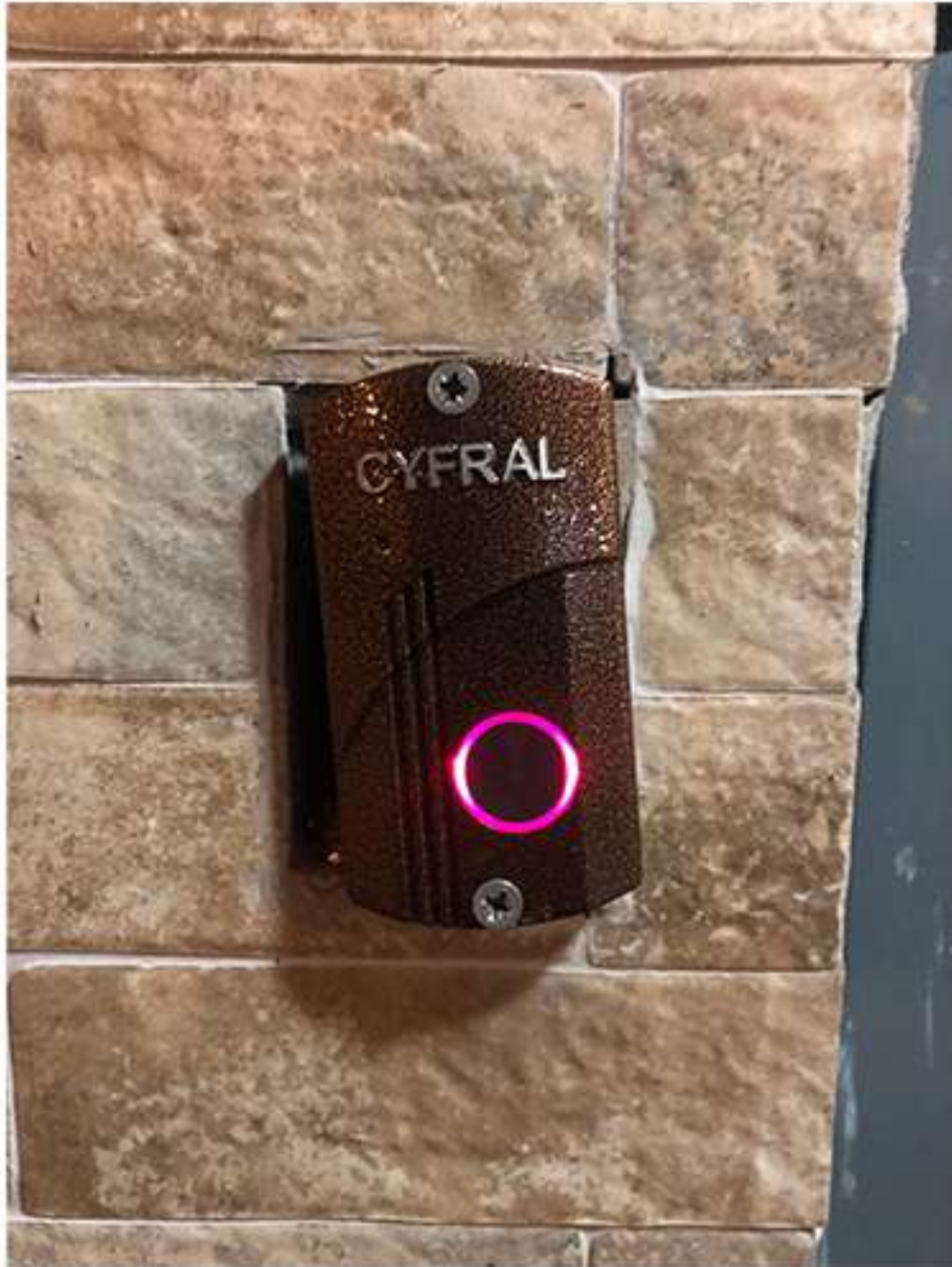
30-03. Кутузовская 23 (3й подъезд). Крепление вызывной панели.
