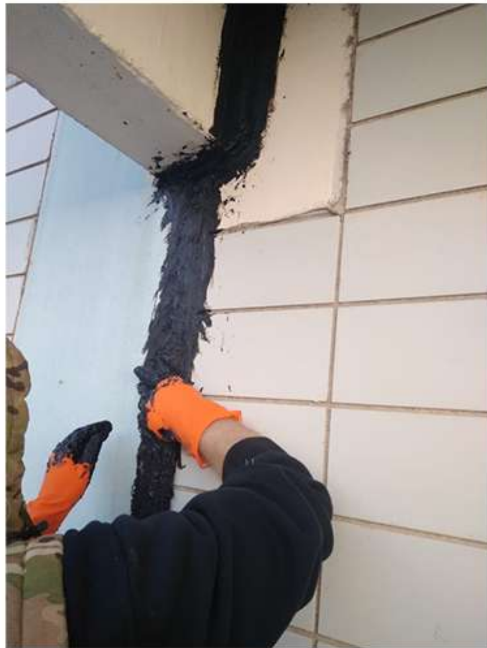
18-03. Кутузовская 23 (6й подъезд). Гидроизоляция межпанельных швов.
