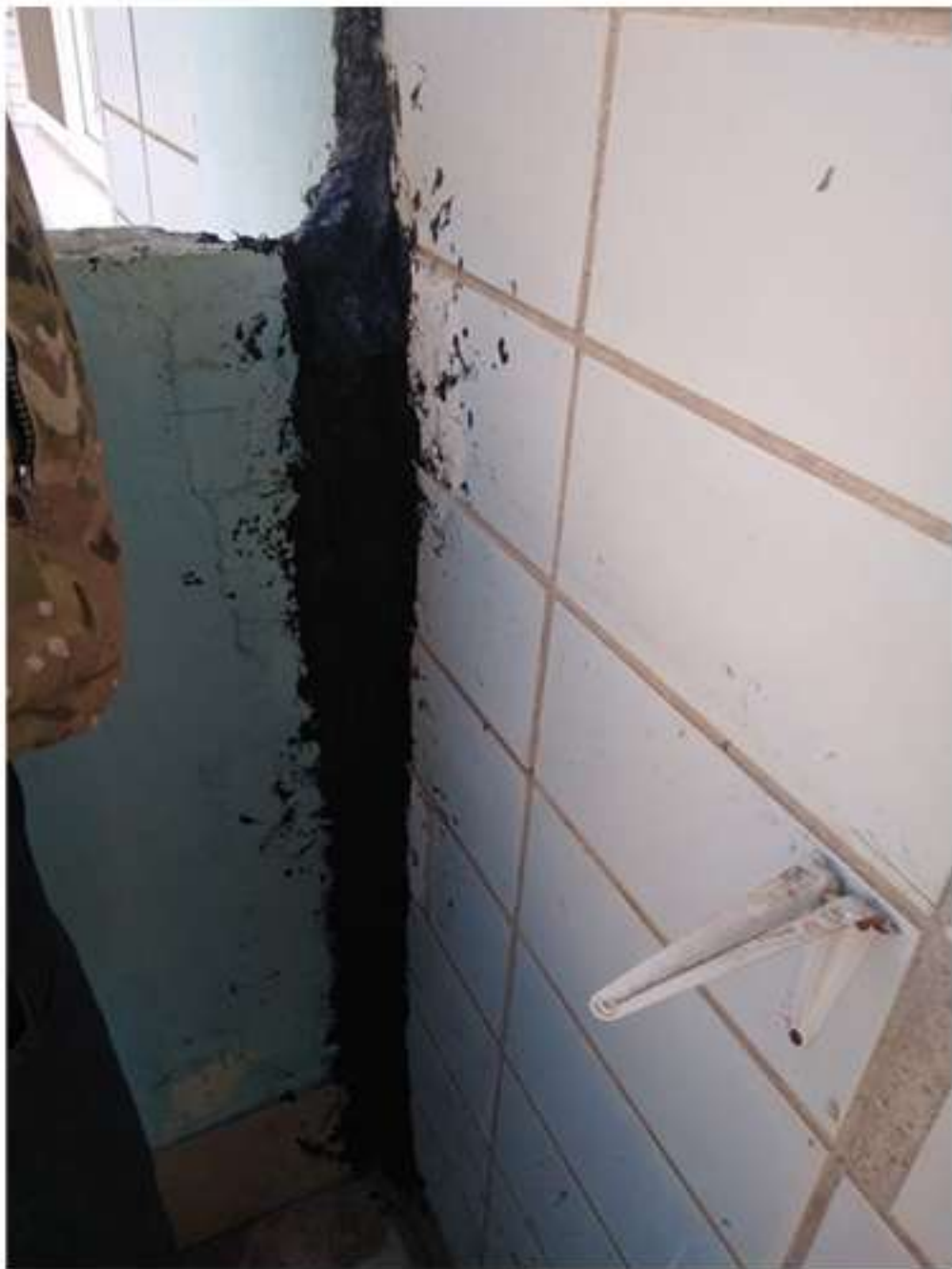
18-03. Кутузовская 23 (6й подъезд). Гидроизоляция межпанельных швов.
