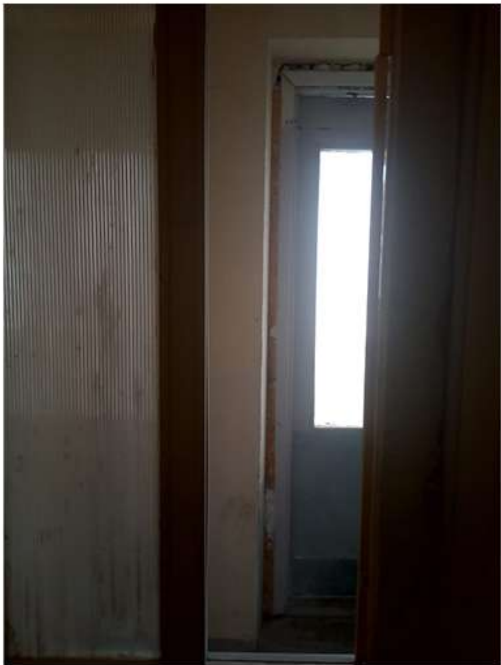
04-03. Кутузовская 23 (5й подъезд; 2й этаж). Ремонт дверей.
