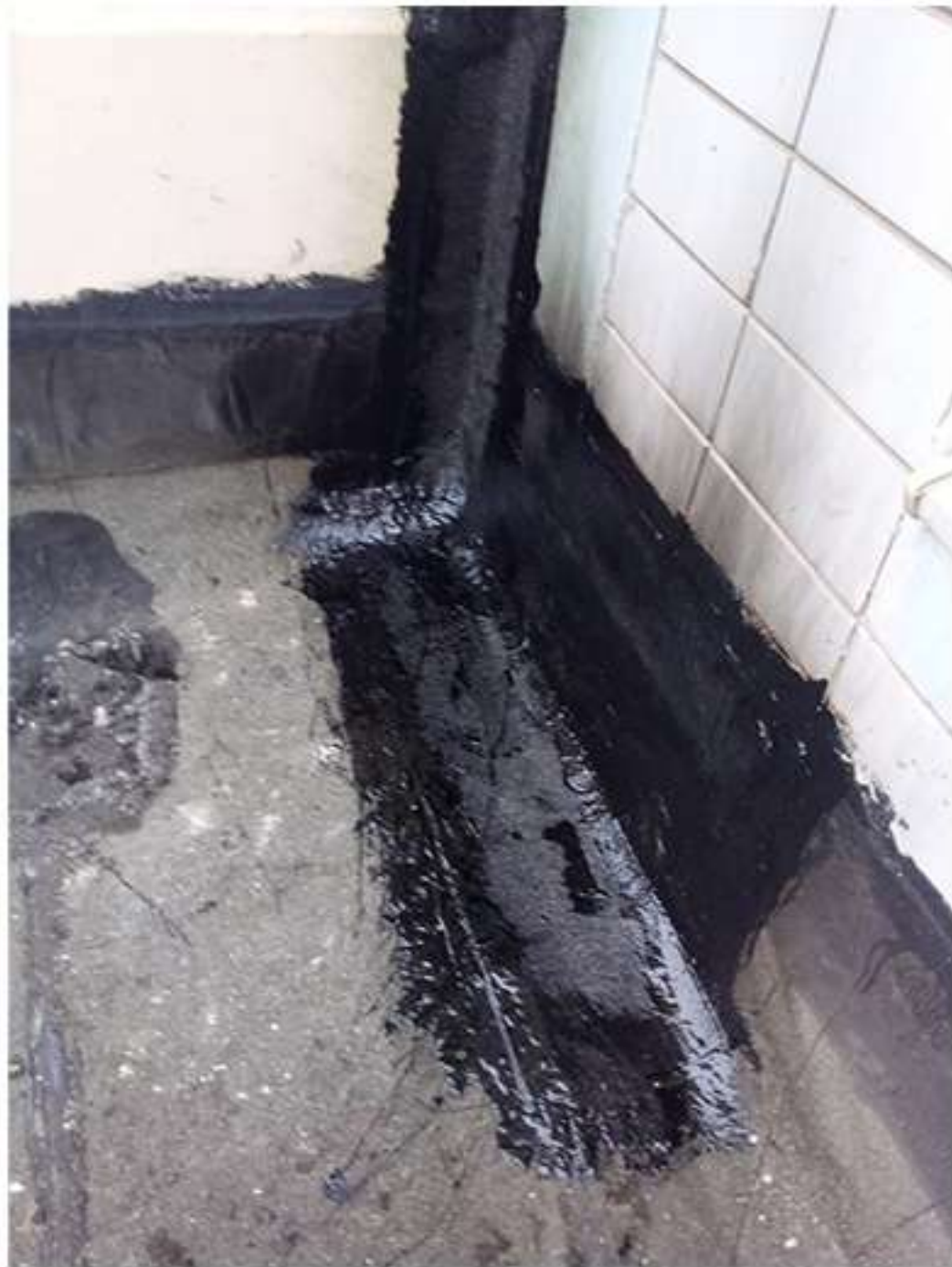
24-02. Кутузовская 23 (6й подъезд). Гидроизоляция козырька.
