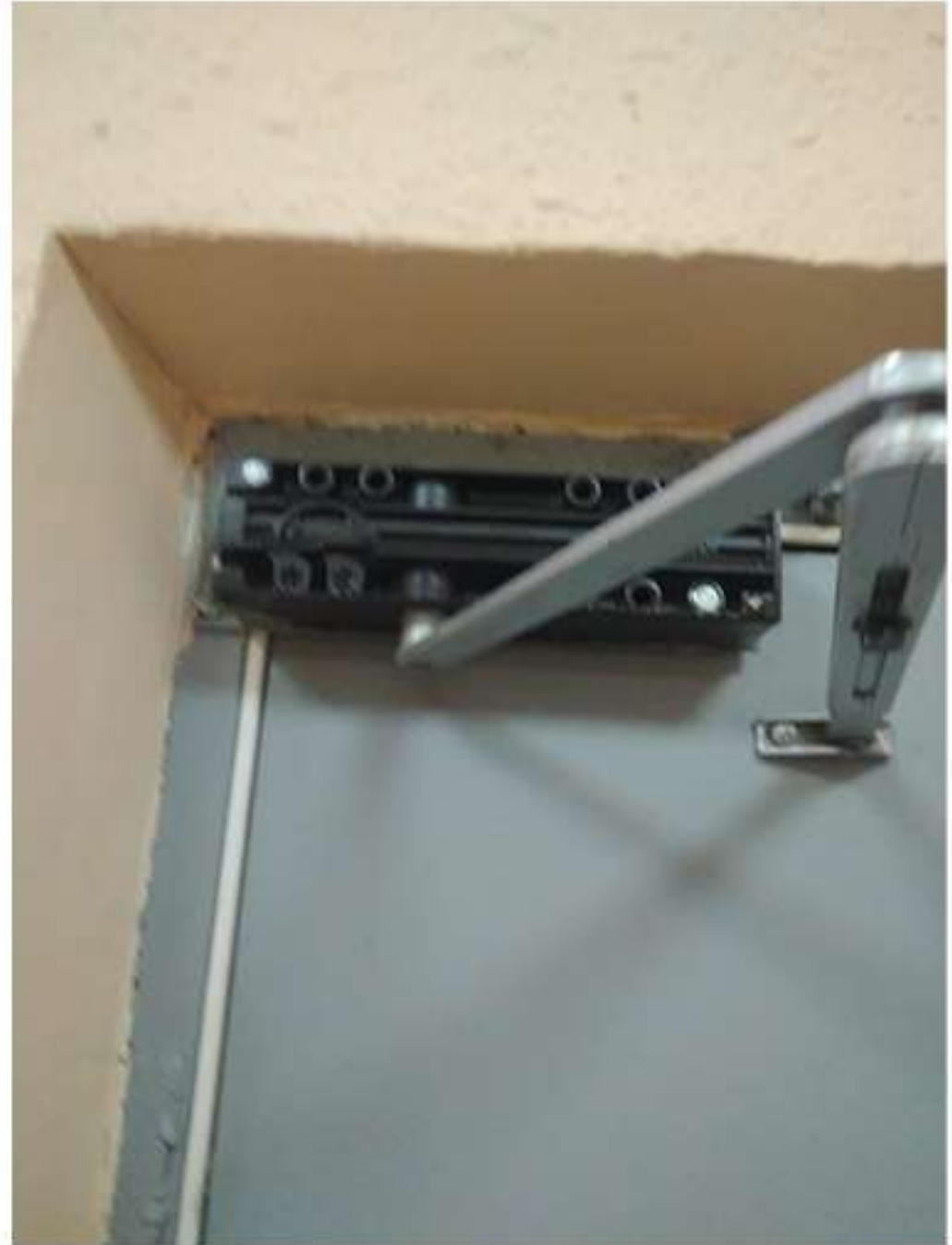
08-02. Кутузовская 23 (6й подъезд) регулировка доводчика.
