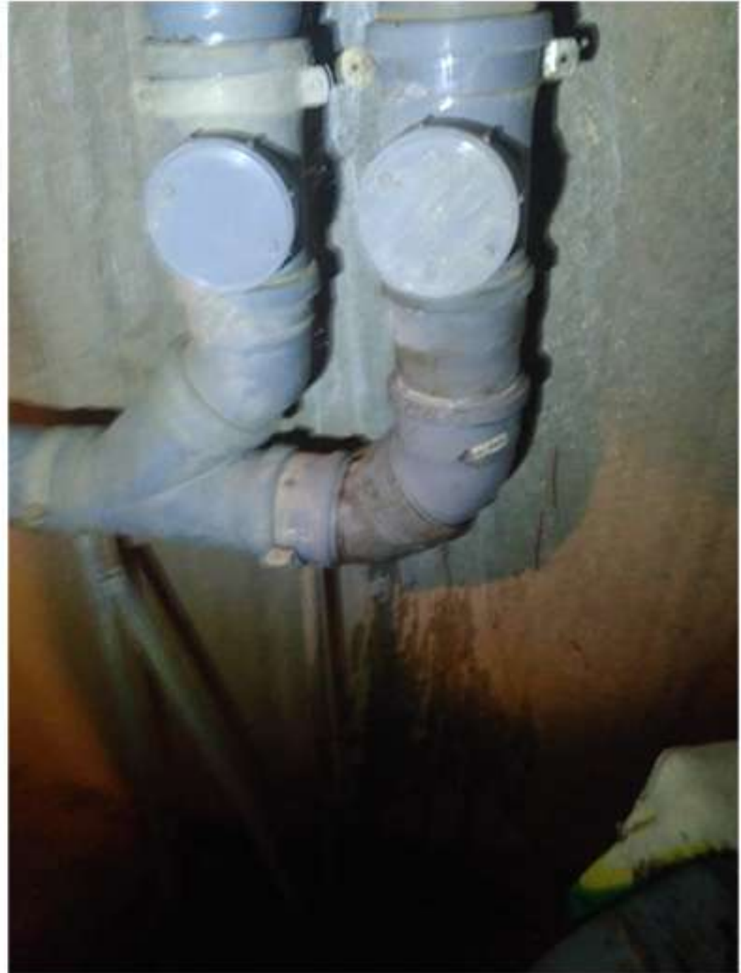
07-02. Кутузовская 23 (3й подъезд). Замена углового сединения трубопровода канализации.
