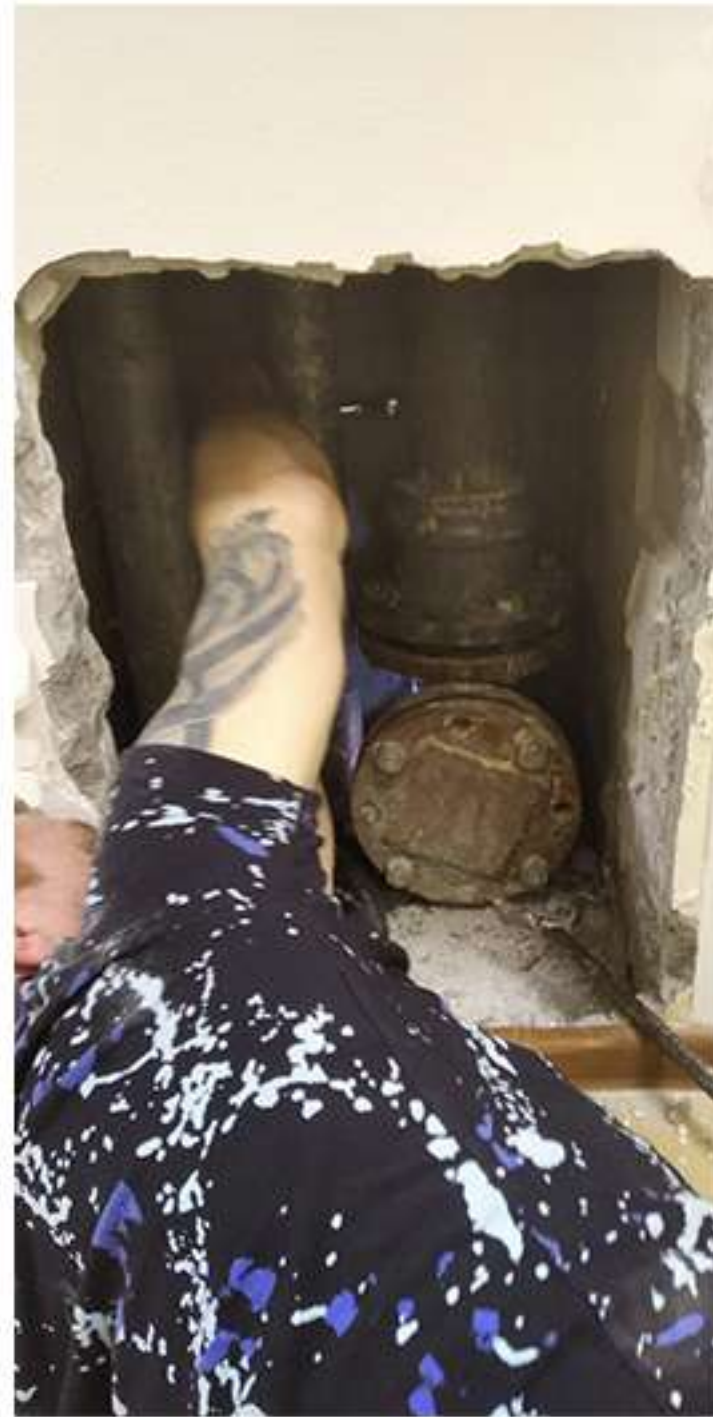
12-02. Кутузовкая 23. «Бублик». Установка прокладки на фланцевом соединении трубопровода ливневой канализации.
