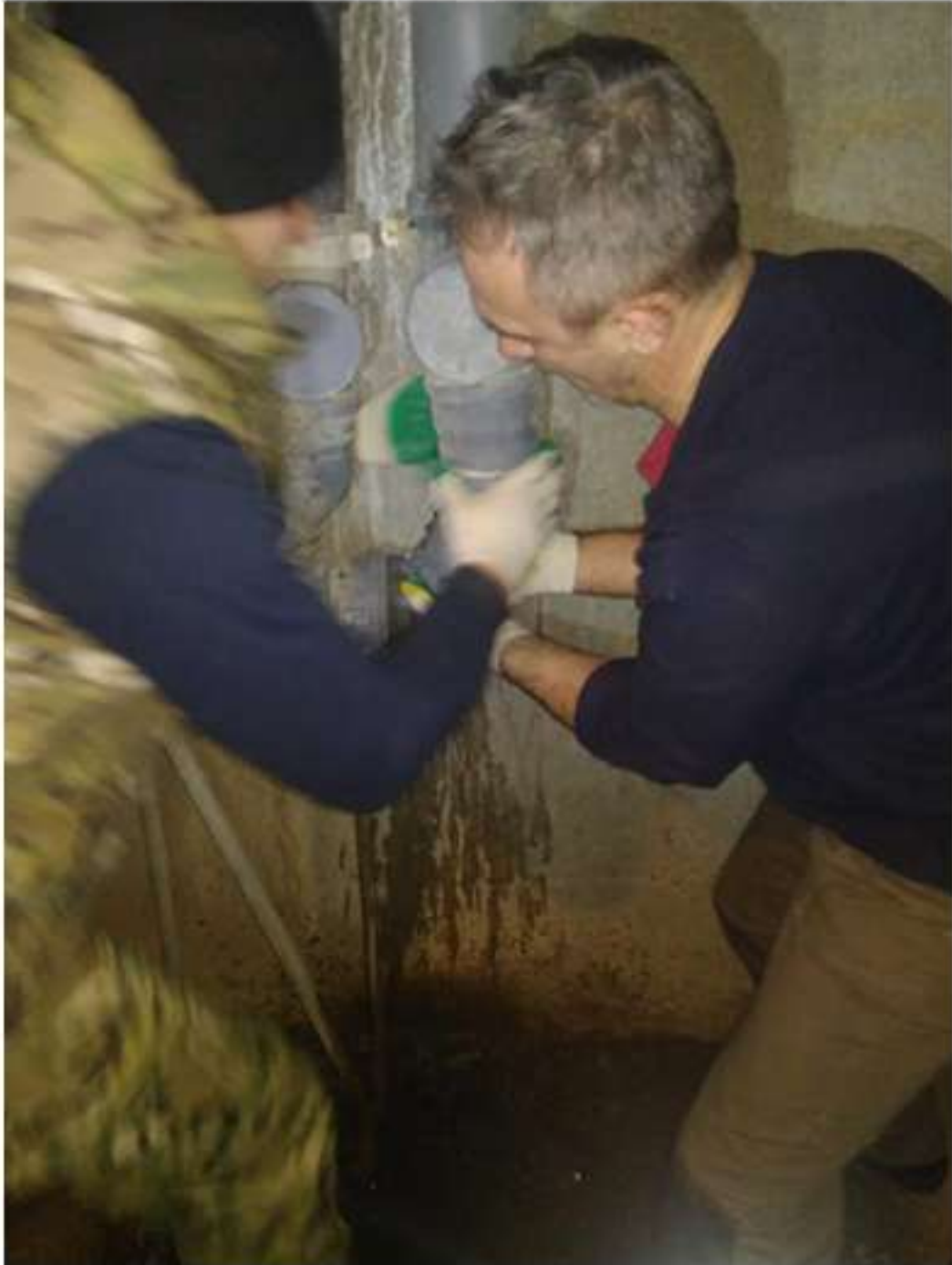
07-02. Кутузовская 23 (3й подъезд). Замена углового сединения трубопровода канализации.
