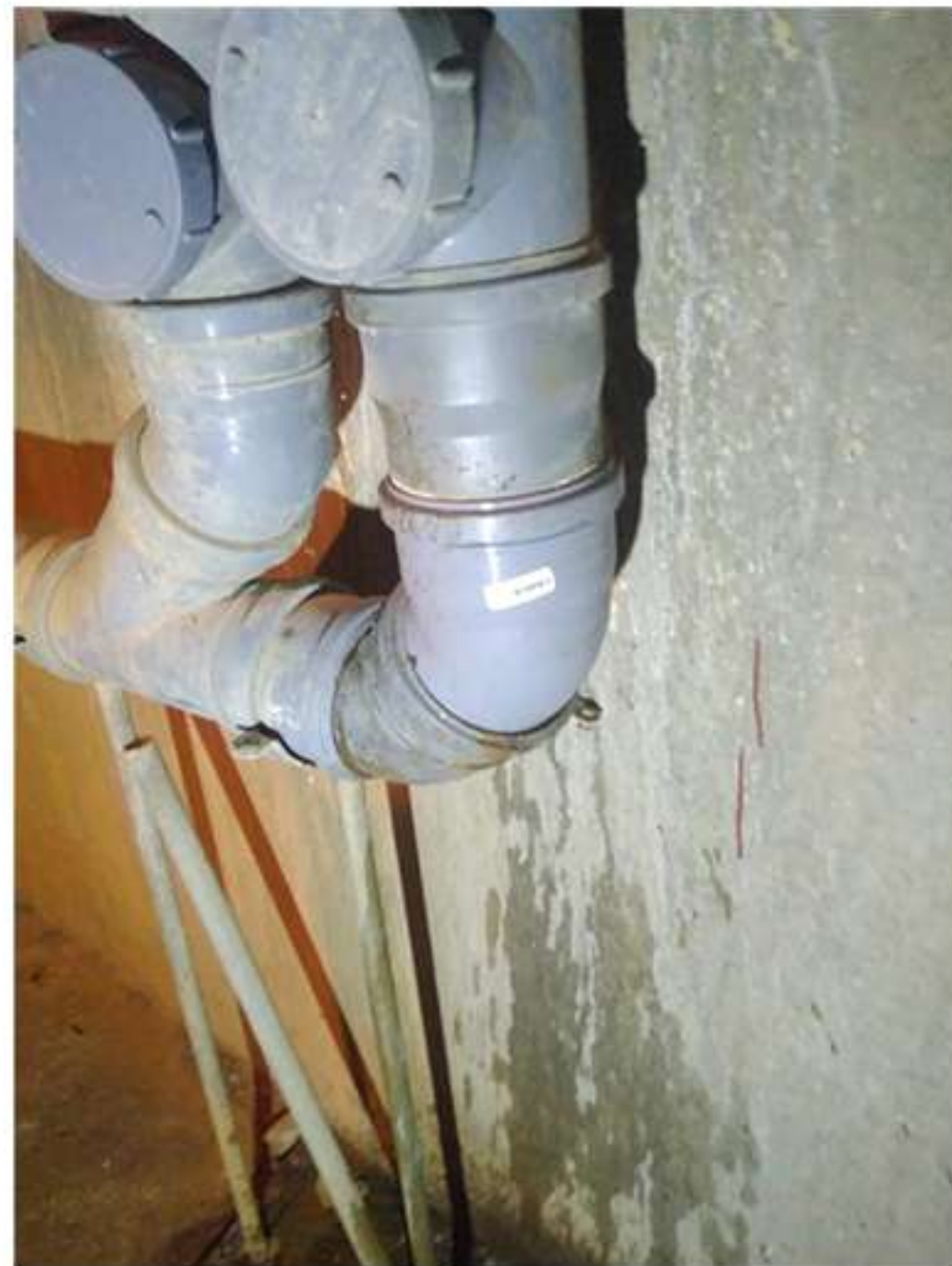
07-02. Кутузовская 23. Замена углового соединения трубопровода канализации.
