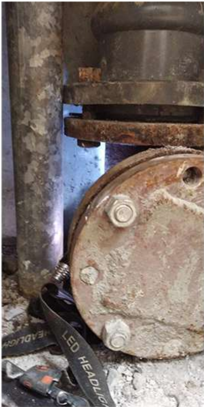
12-02. Кутузовкая 23. «Бублик». Установка прокладки на фланцевом соединении трубопровода ливневой канализации.
