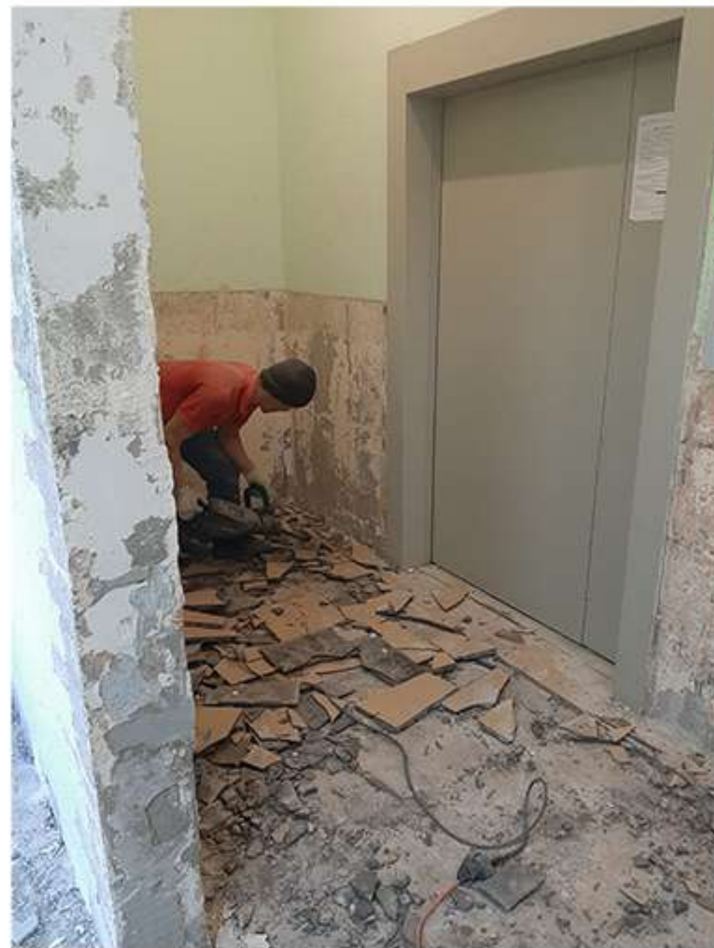
23-02. Кутузовская 23. Демонтаж напольного покрытия.
