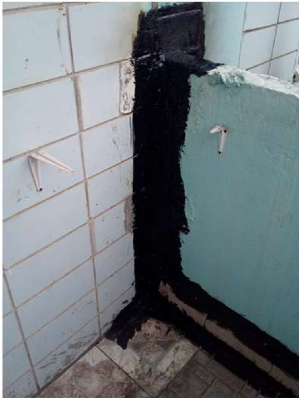
24-02. Кутузовская 23 (6й подъезд). Гидроизоляция козырька.
