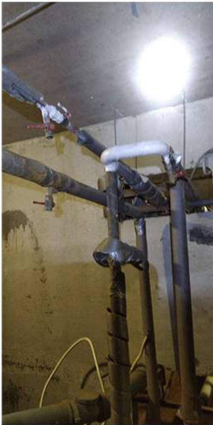
16-02. Кутузовская 23 (4й подъезд). Переварка с покраской трубопровода ГВС.
