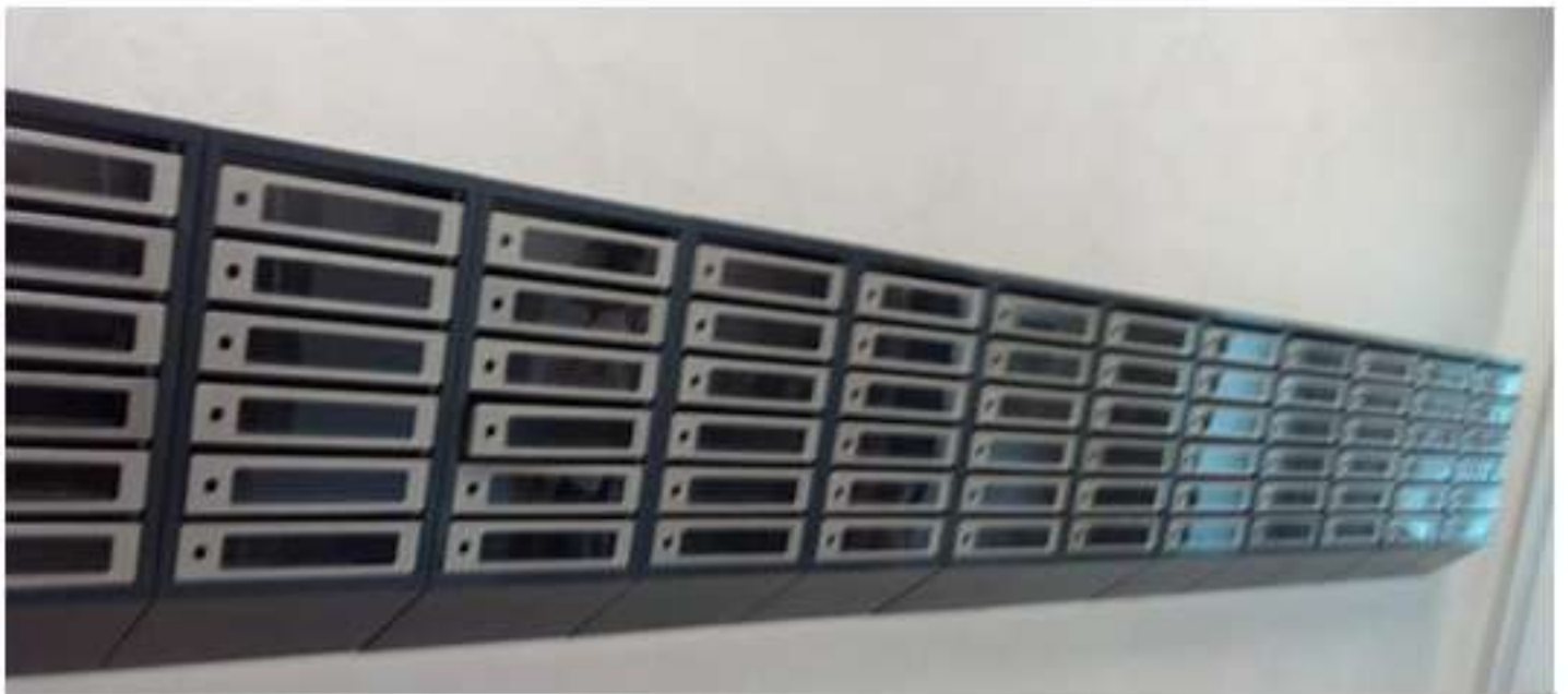
03-06. Кутузовская 23. Установка почтовых ящиков (3й, 5й подъезды)
