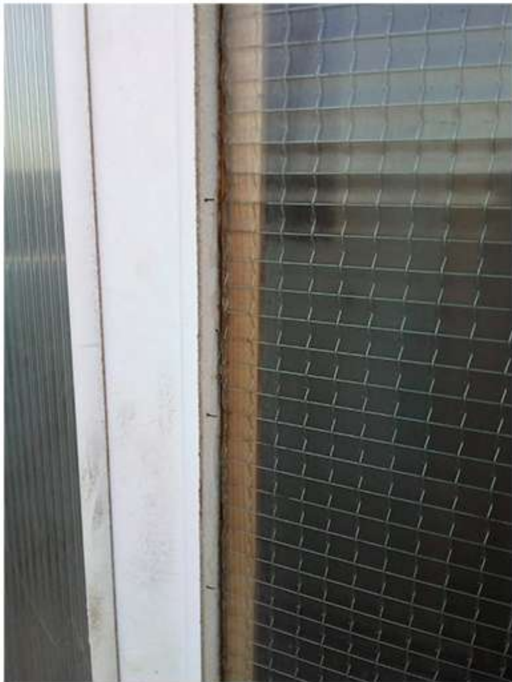
16-02. Кутузовская 33 (2й подъезд, 7й этаж). Установка штапиков.
