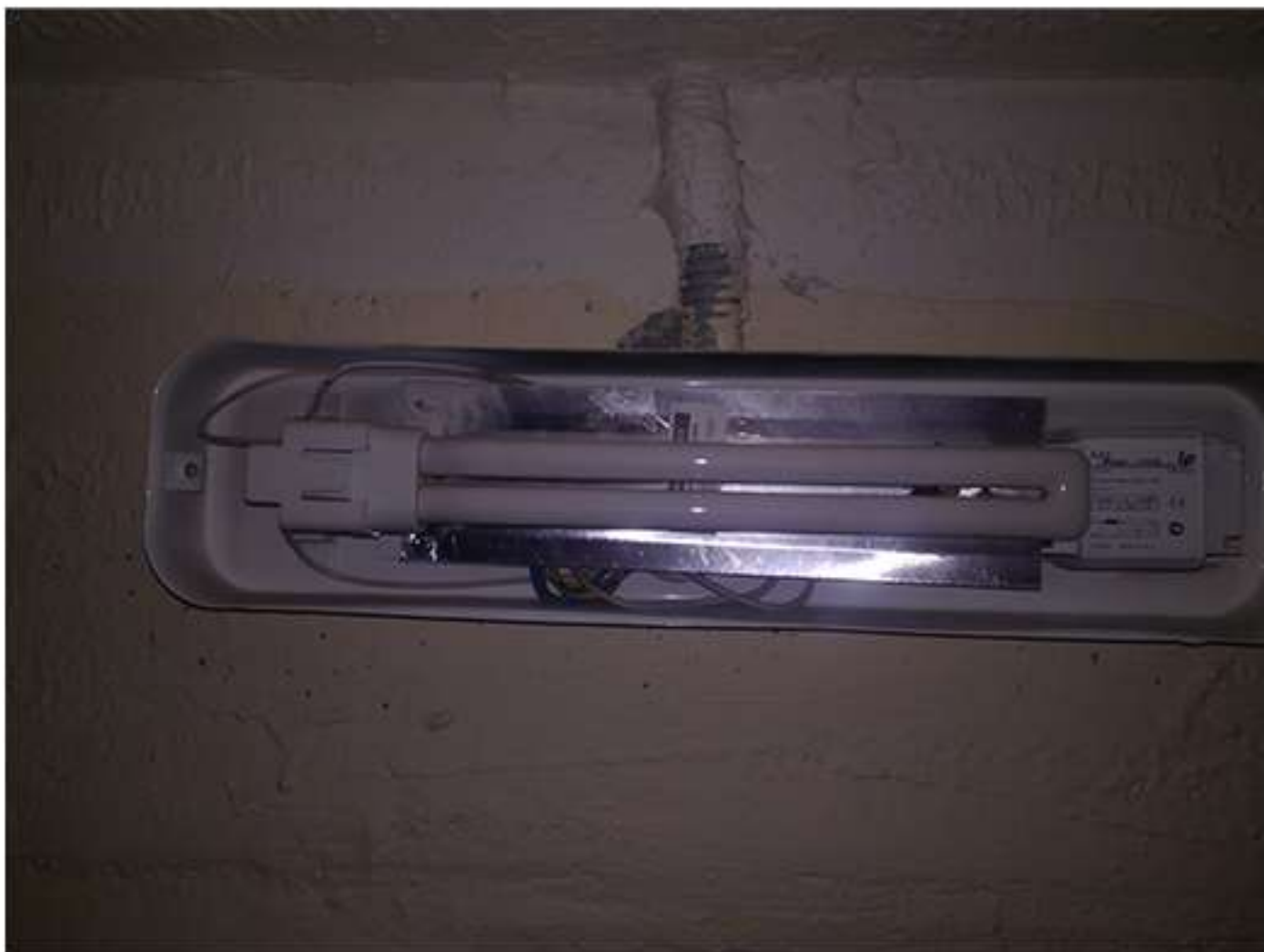
03-02. Кутузовская 33 (2й подъезд, 10й этаж). Установка плафона.
