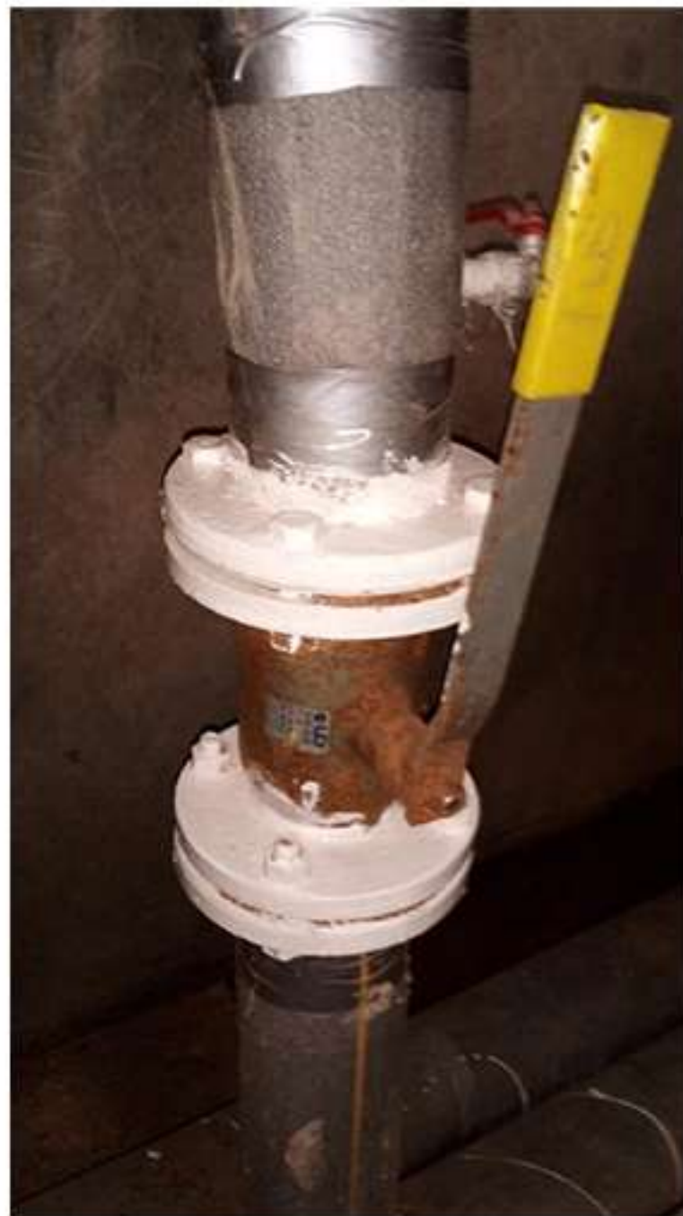
08-02. КУтузовская 33. Зачистка и грунтовка фланцевых соединений.
