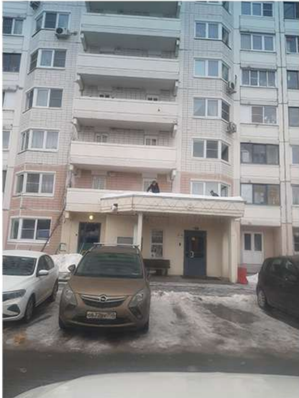
21-02. Кутузовская 33. Очистка козырьков от снега.
