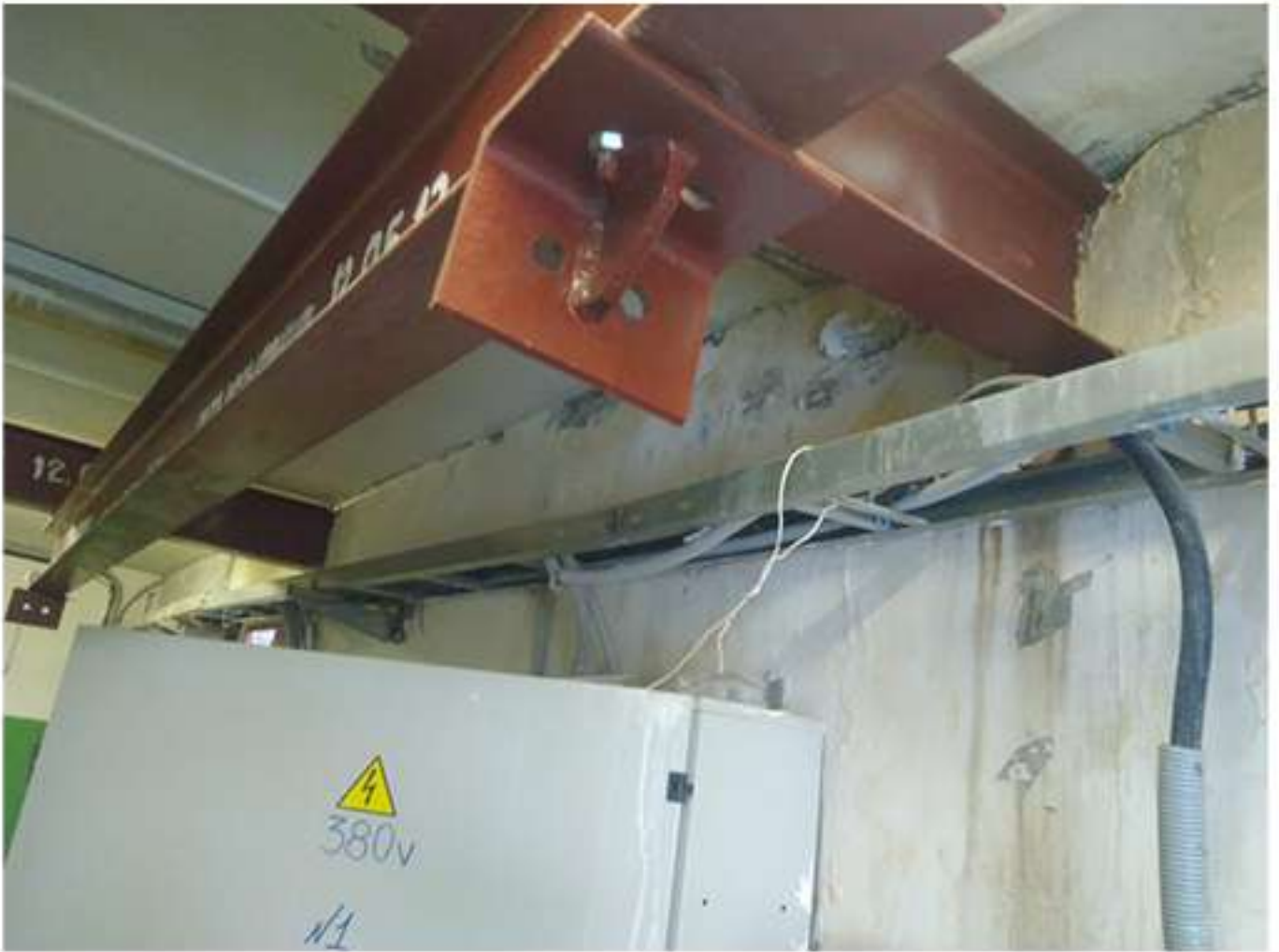
16-02. Кутузовсакая 33. Обход лифтовых на предмет протечек.
