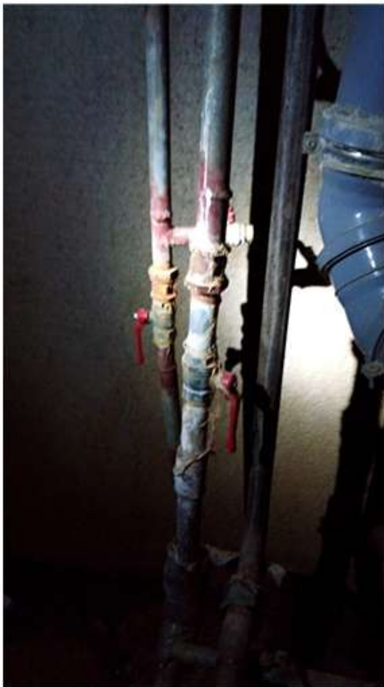
08-02. Кутузовская 33. Зачистка и грунтовка резьбовых соединений.
