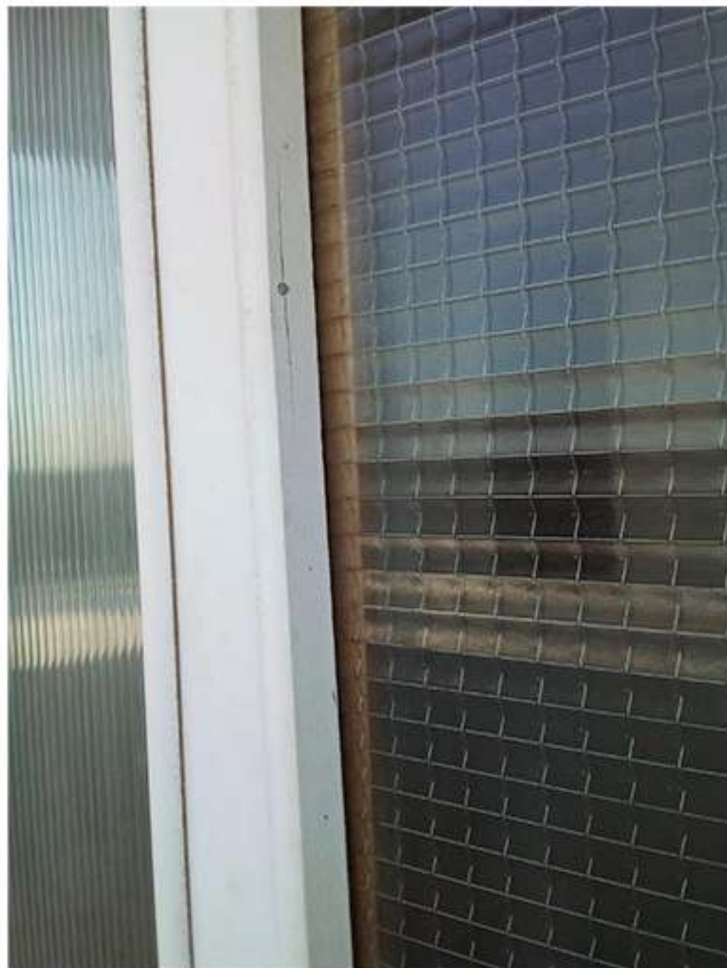
16-02. Кутузовская 33 (2й подъезд, 7й этаж). Установка штапиков.
