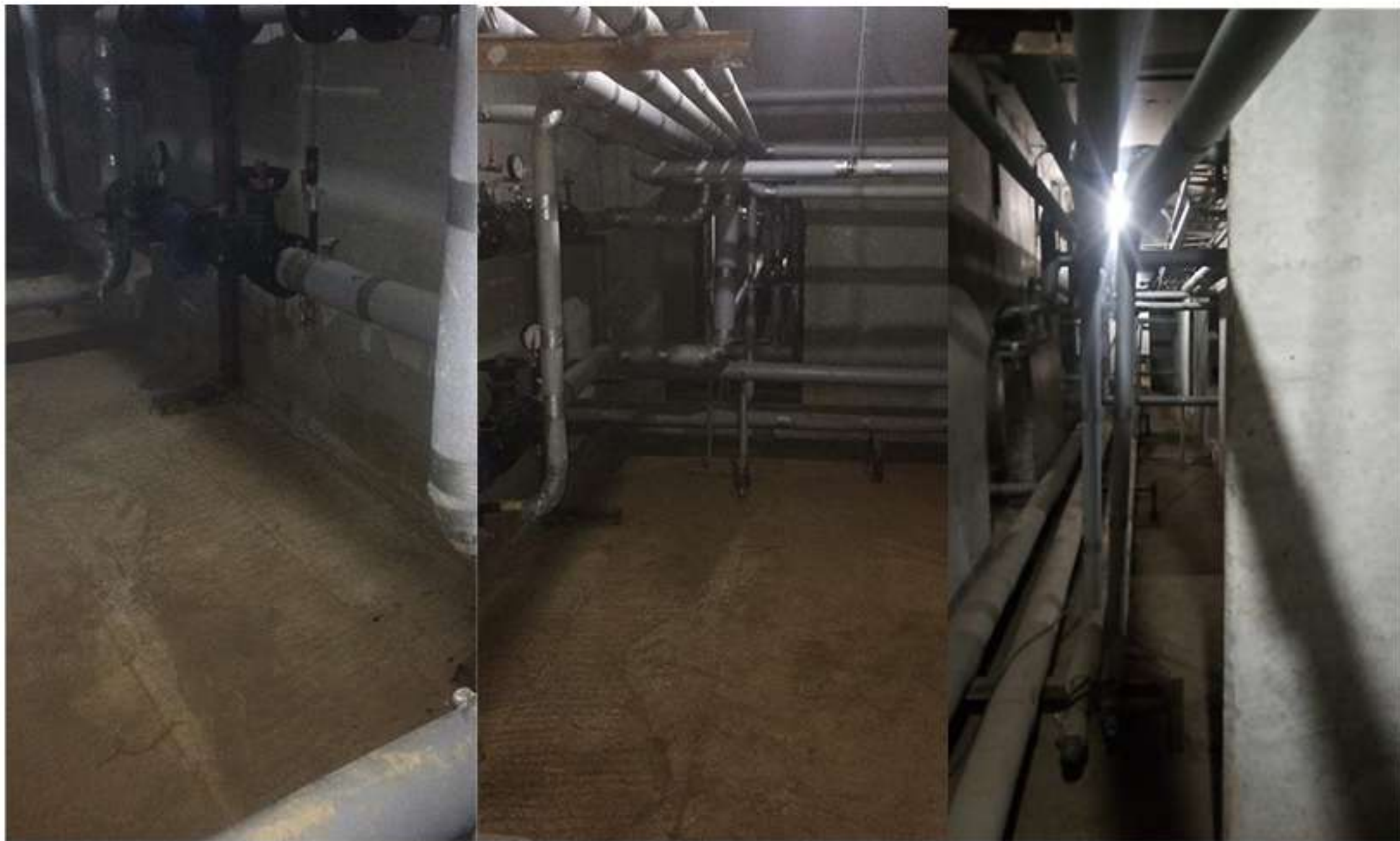
Кутузовская 23. Обход подвалов.
