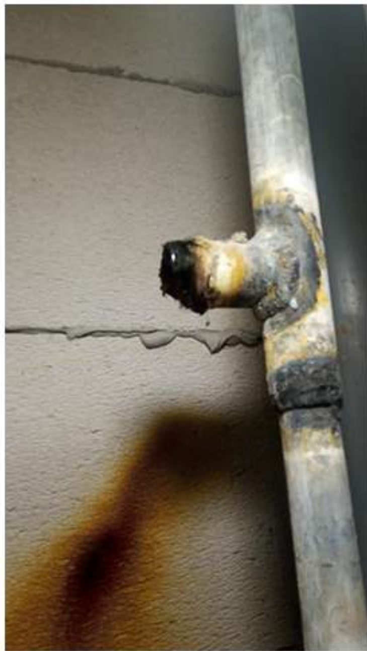
Кутузовская 23 кв.86. Переварка отвода на полотенцесушитель.
