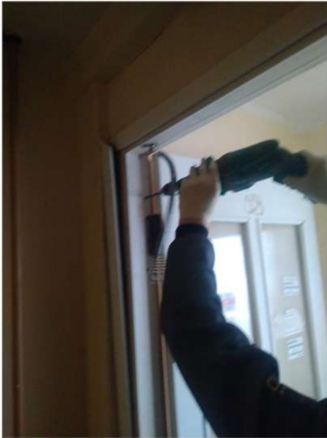
Кутузовская 23 (4й подъезд, 5й этаж). Крепление дверных коробок.
