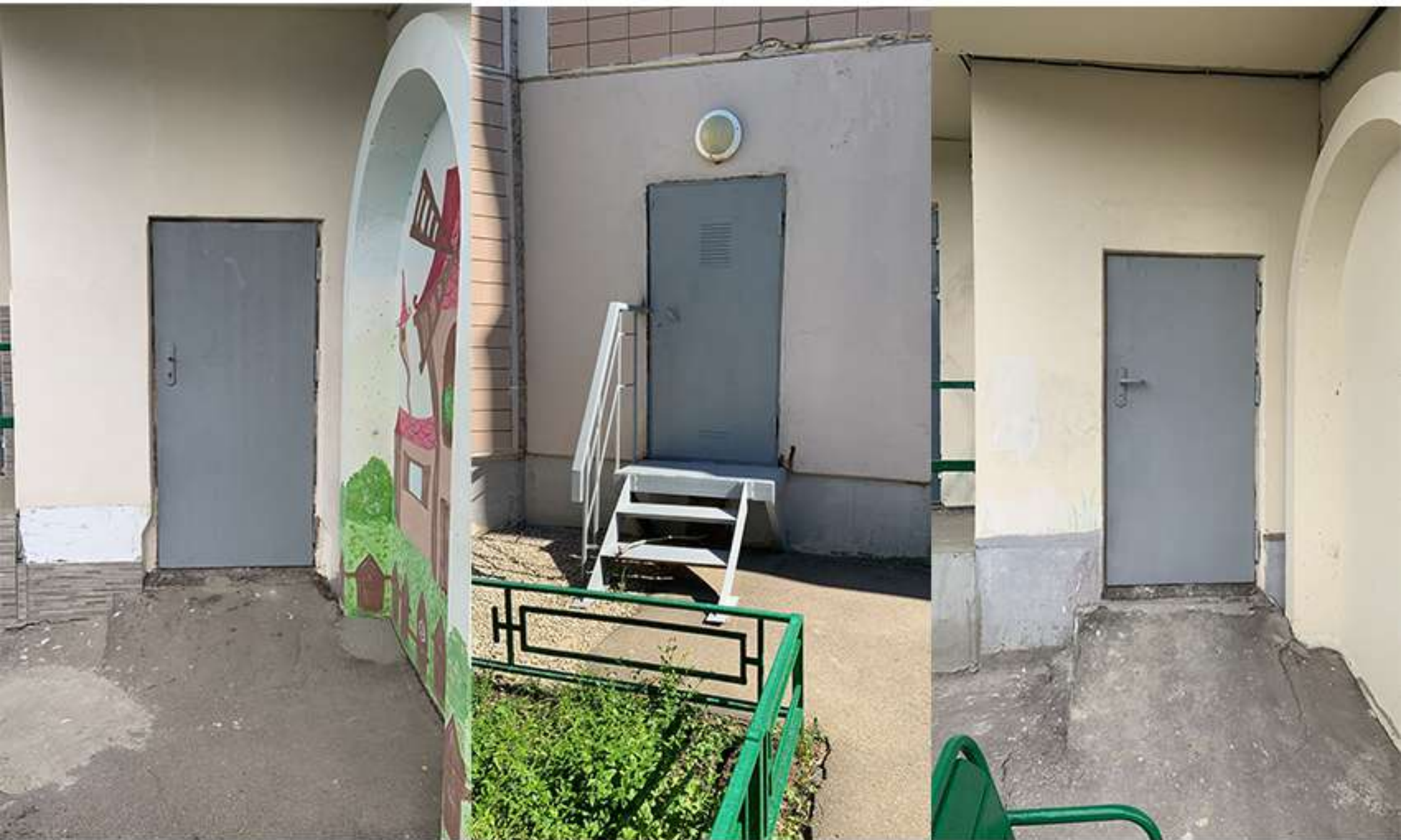
Кутузовская 33. Покраска дверей мусорокамер и ВРУ.
