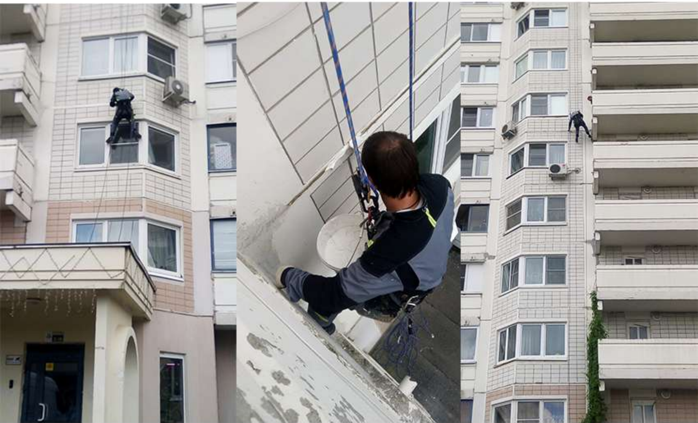
Кутузовская 33. Заделка межпанельных швов.
